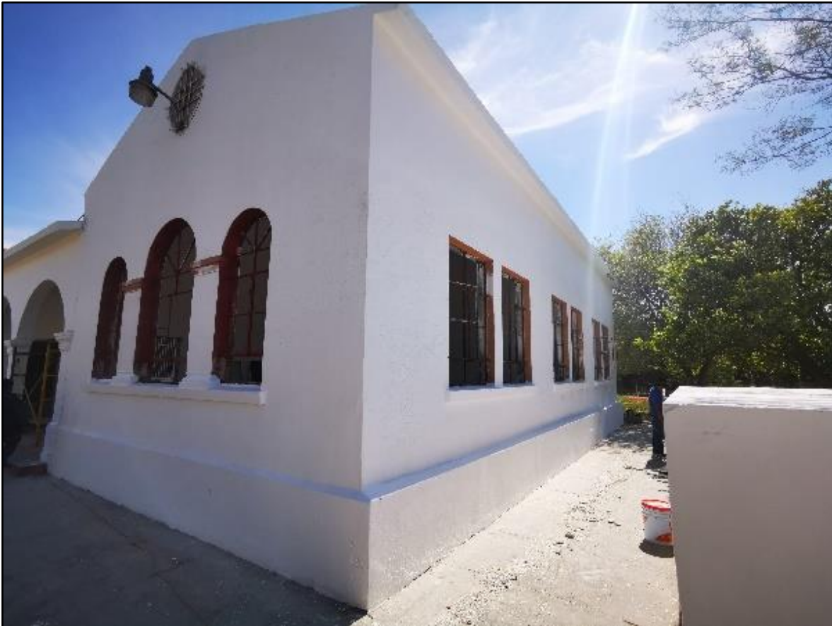
Figura 67. Muros exteriores del inmueble
