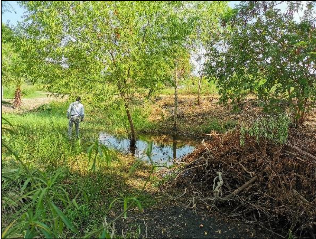
Figura 143. Verificación de estado de drenes
