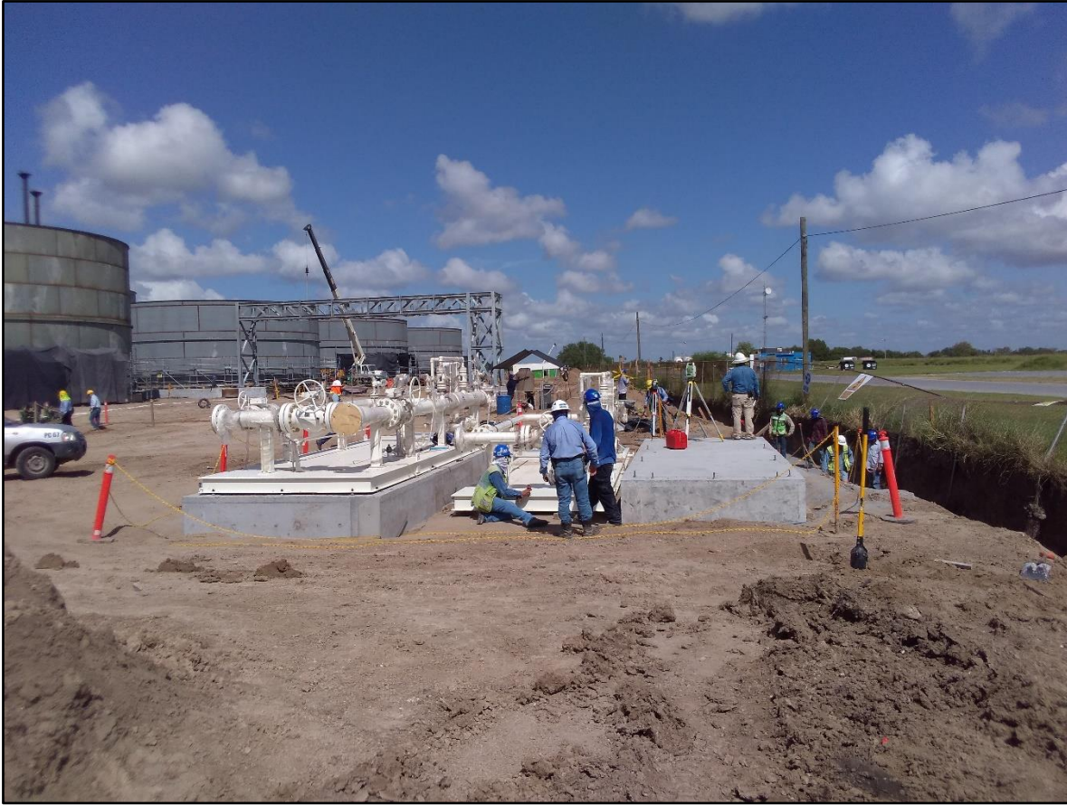
Figura 21. Empresas locales realizando trabajos en el Proyecto TRB
