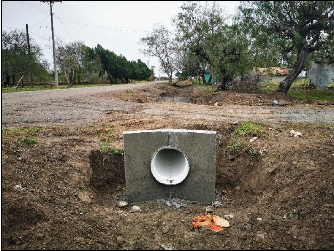
Figura 129. Vista final de la tubería pluvial instalada
