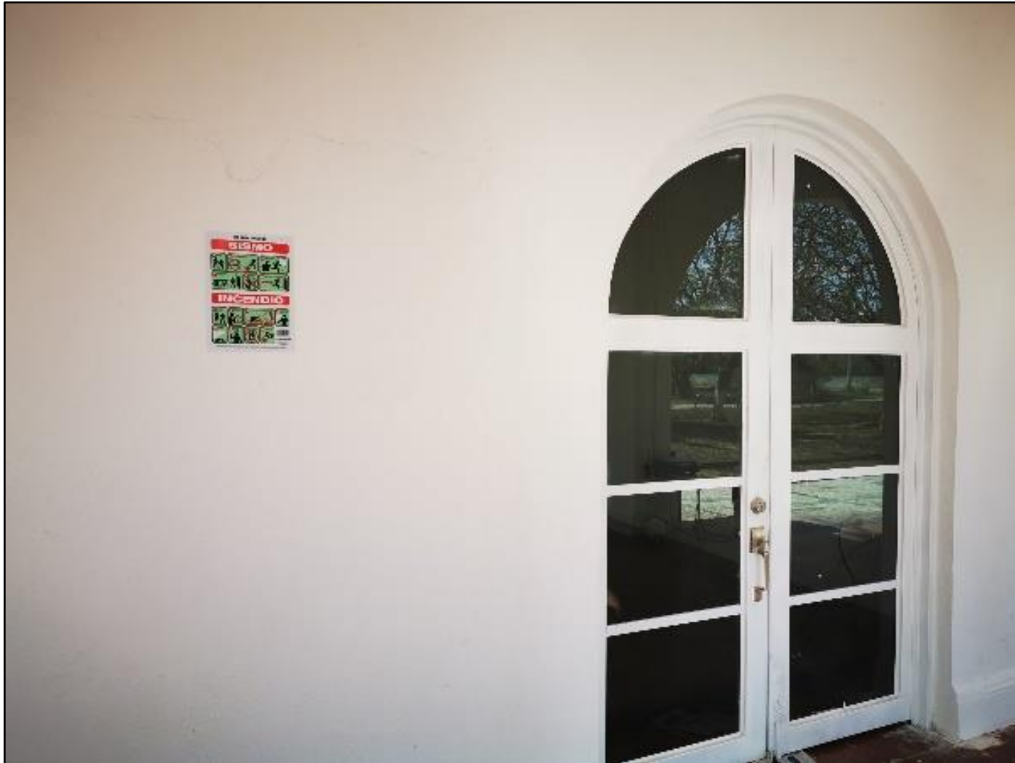
Figura 80. Nueva entrada en puerta principal de la escuela
