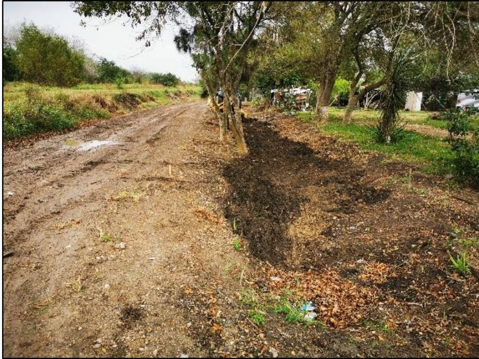
Figura 165. Desazolve de drenes para instalación de tubería
