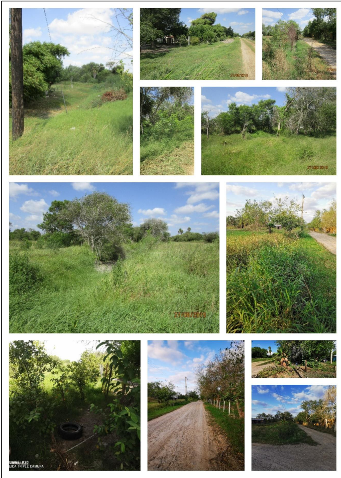
Figura 145. Vista general del estado inicial de los drenes pluviales
