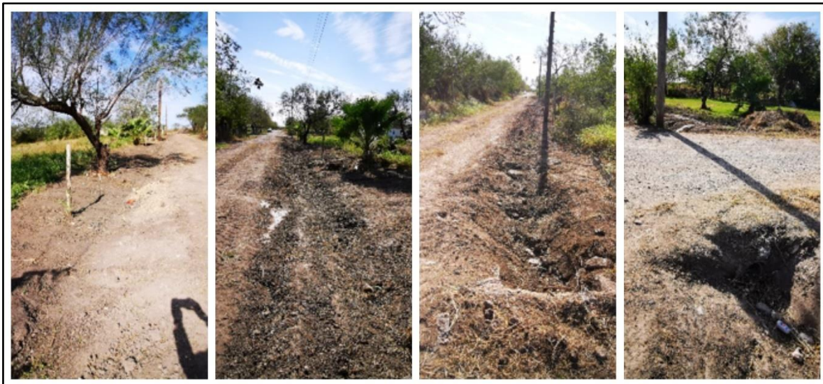
Figura 160. Vista general de obras de desazolve en ejido Santa Irene
