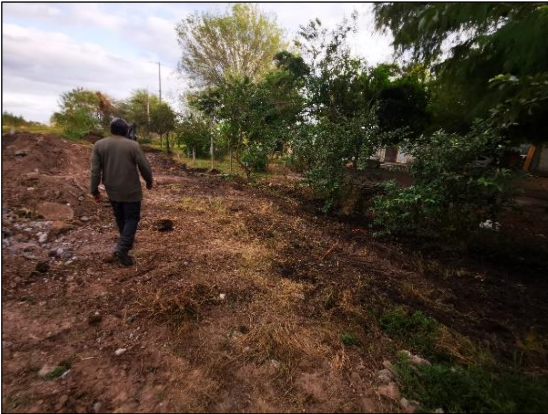
Figura 149. Trabajos de limpieza inicial
