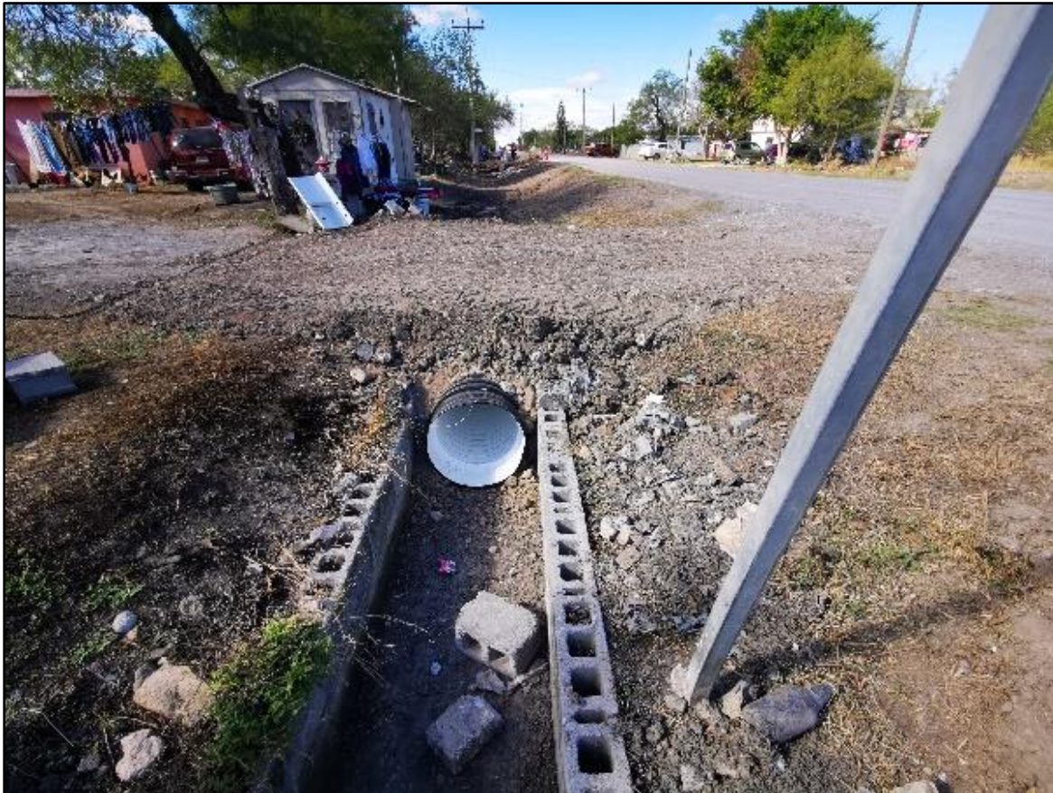
Figura 126. Instalación de tuberías en cruce de calles.
