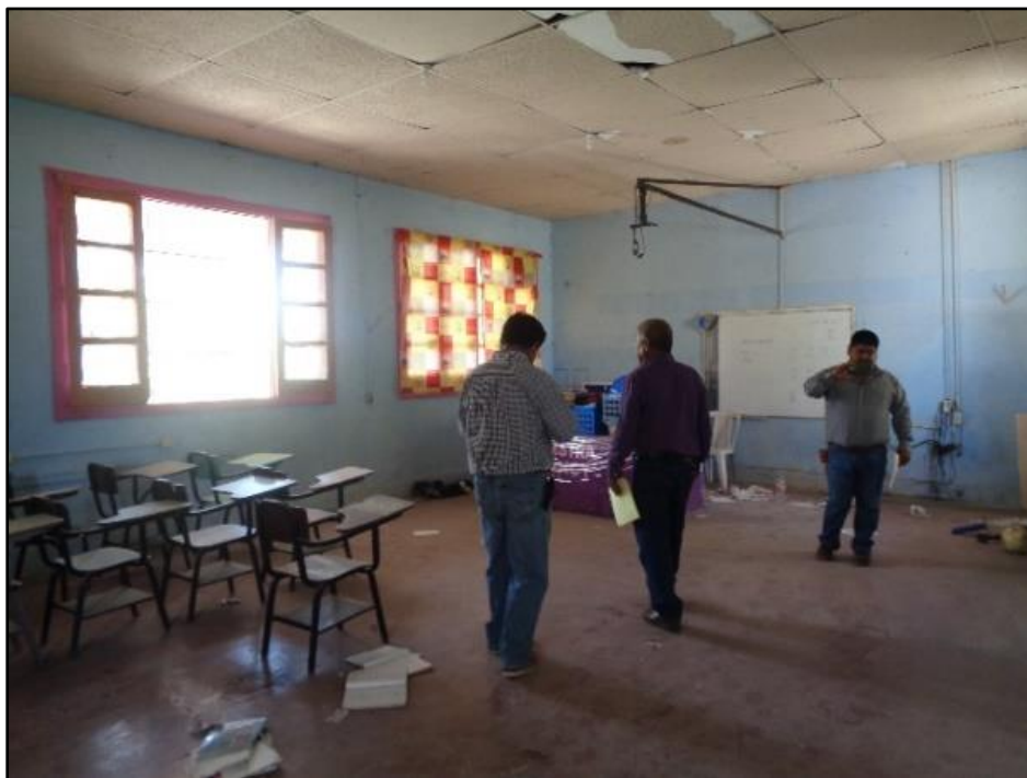
Figura 61. Recorrido de inspección por parte de contratistas locales
