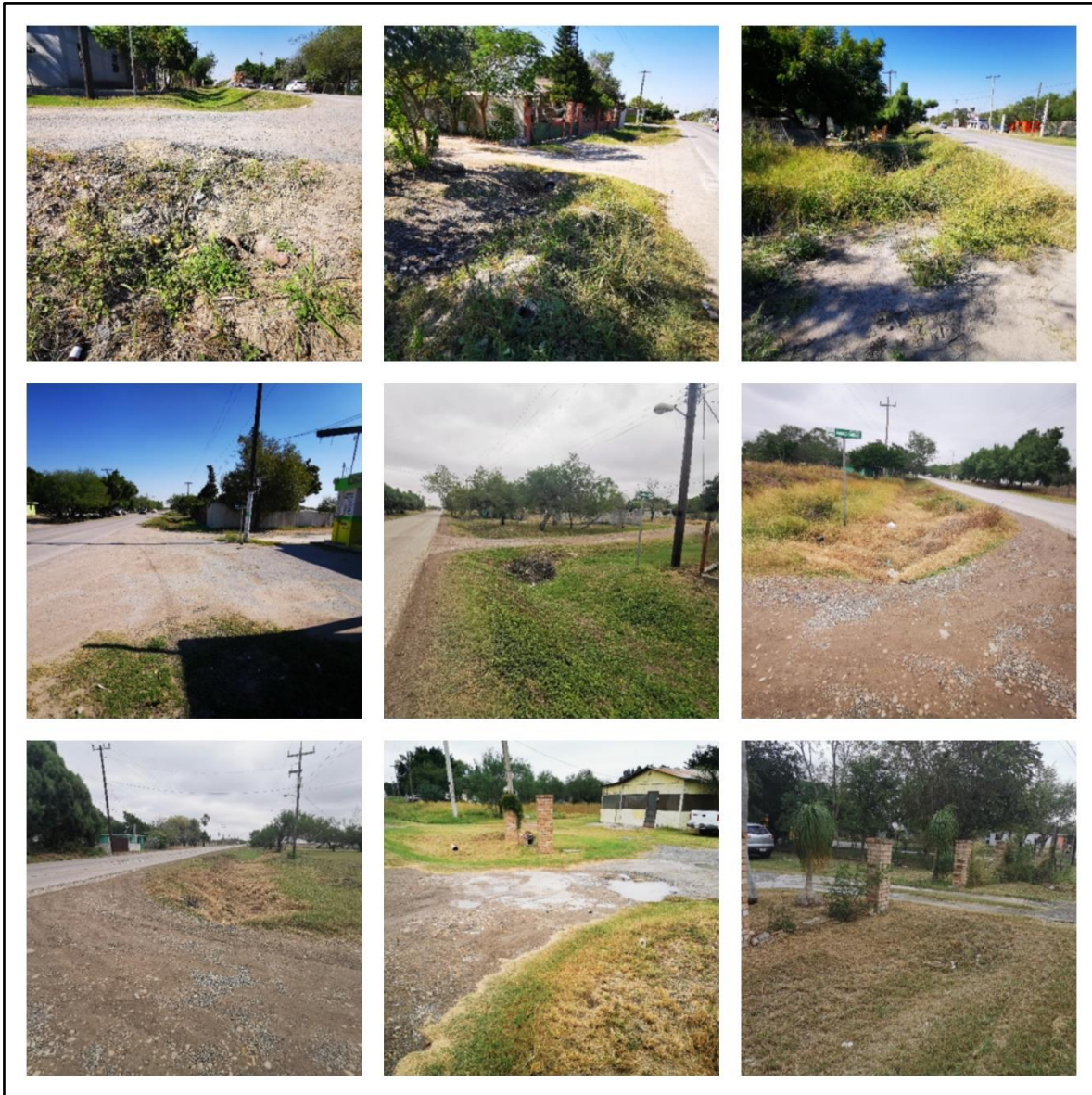
Figura 112. Vista general del estado inicial de la infraestructura pluvial
