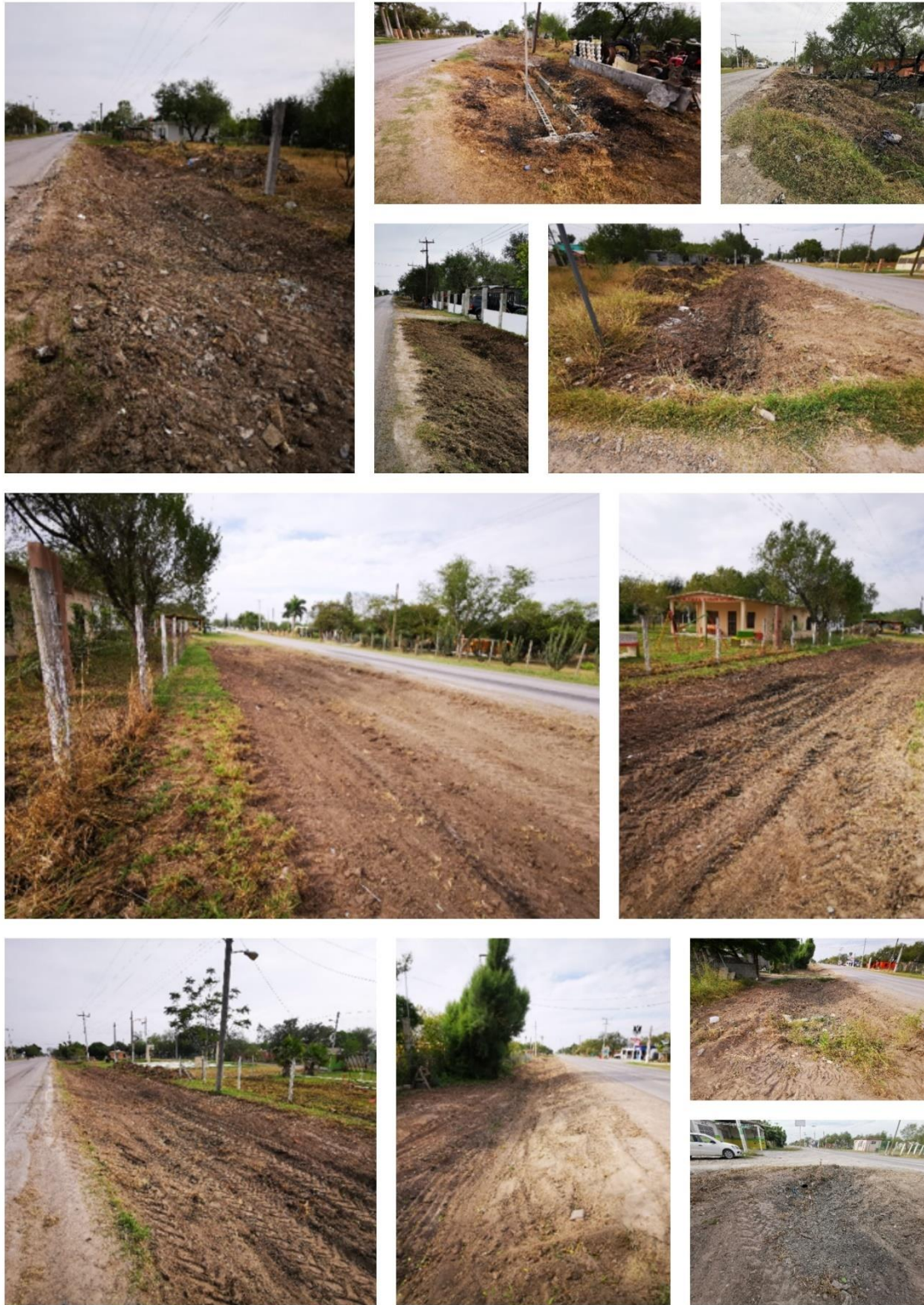
Figura 120. Avances iniciales en la obra de rehabilitación de drenes pluviales
