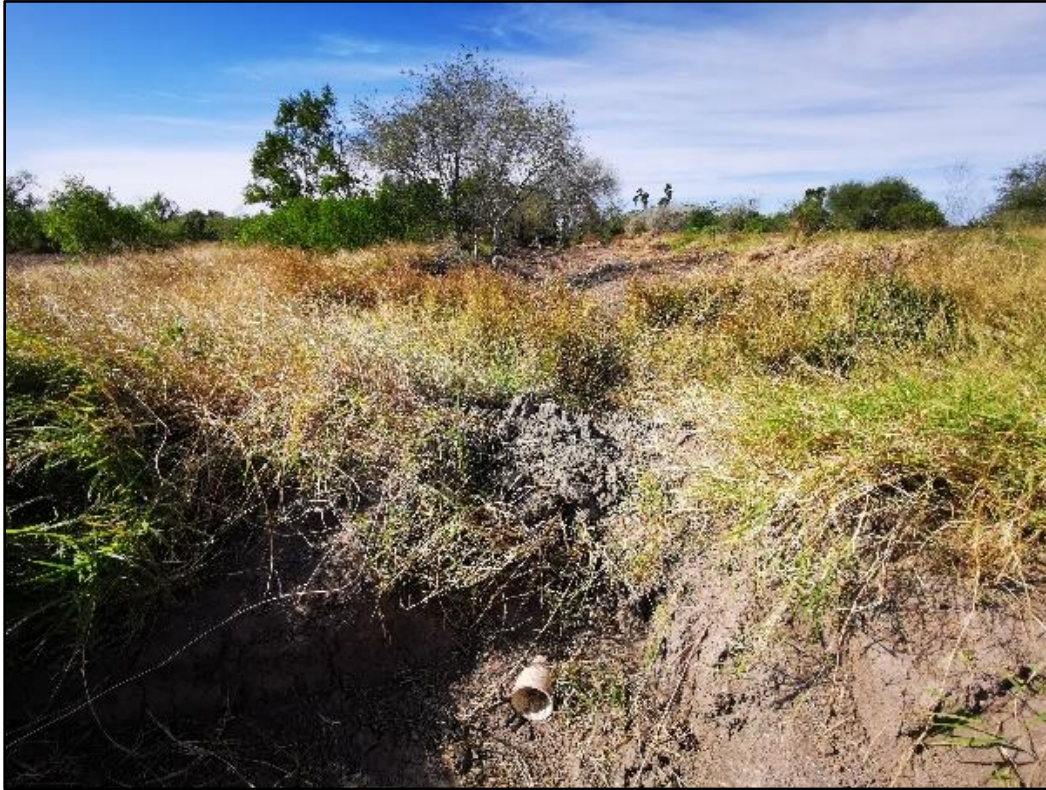
Figura 159. Adecuaciones previas en drenes pluviales
