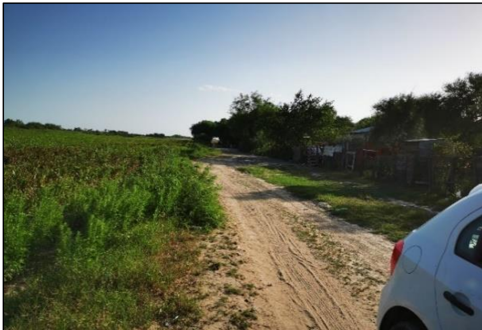
Figura 196. Falta de mantenimiento en calles de El Sabinito
