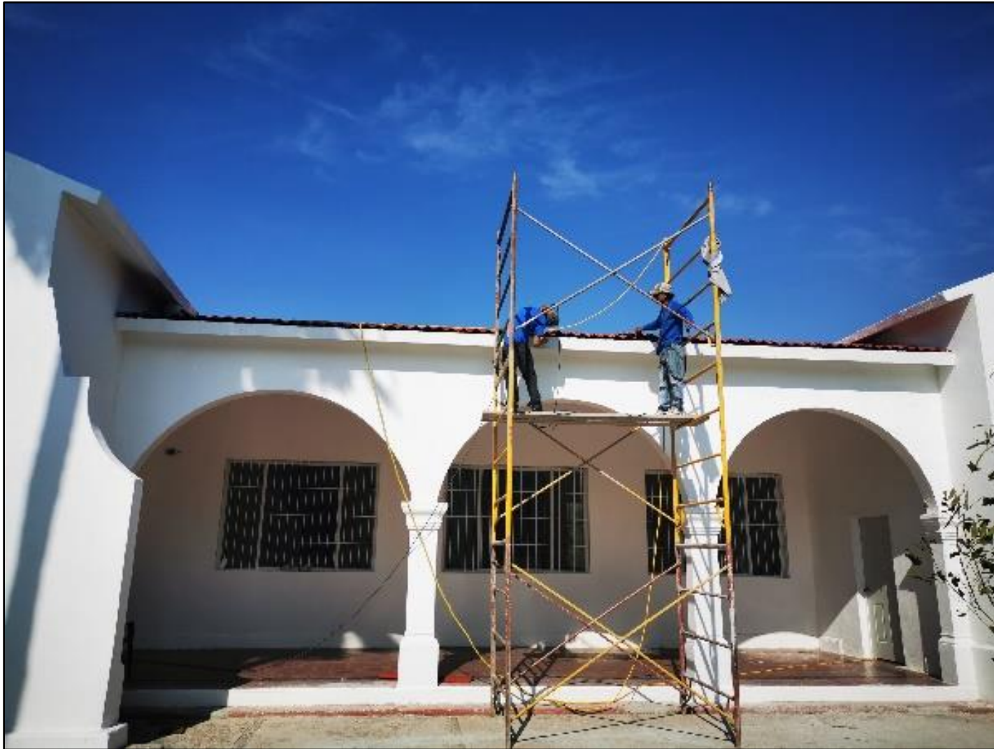
Figura 73. Acabados en la fachada y terminados en nuevo techo
