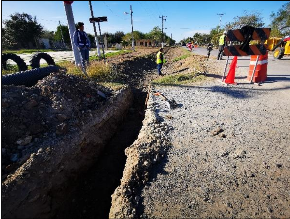
Figura 122. Apertura de zanjas para instalación de tubería pluvial
