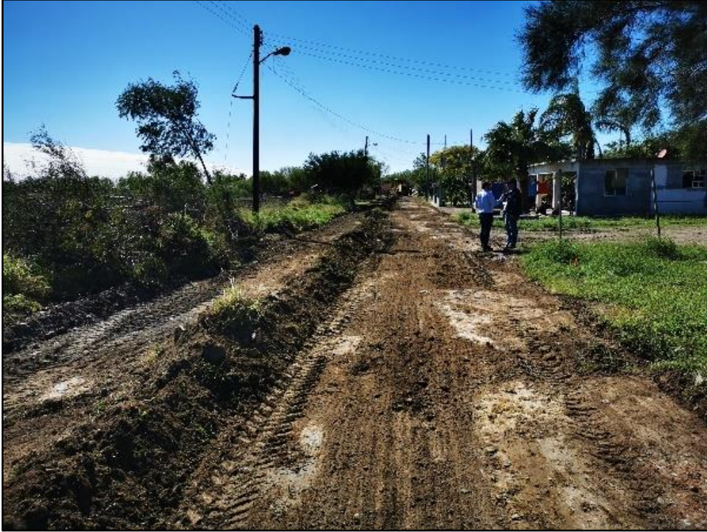
Figura 200. Trabajos en los caminos de El Sabino
