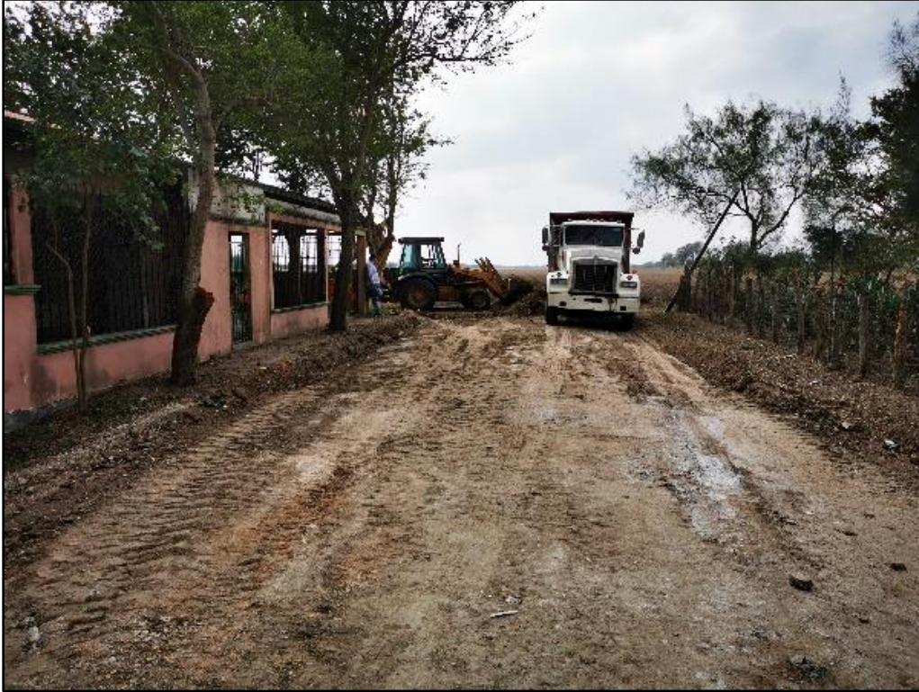
Figura 211. Avance en rehabilitación de calles en El Sabino
