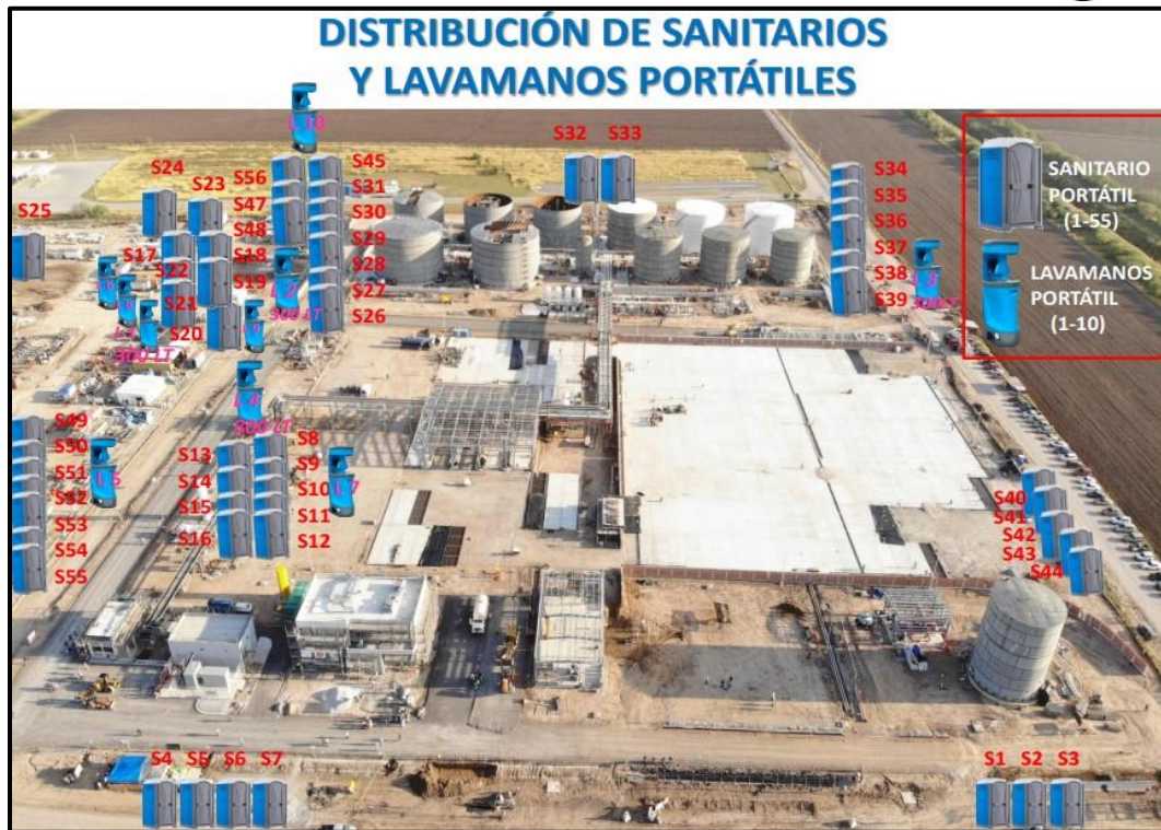
Figura 12. Distribución de sanitarios y lavamanos en la Terminal para tratamiento de aguas residuales
