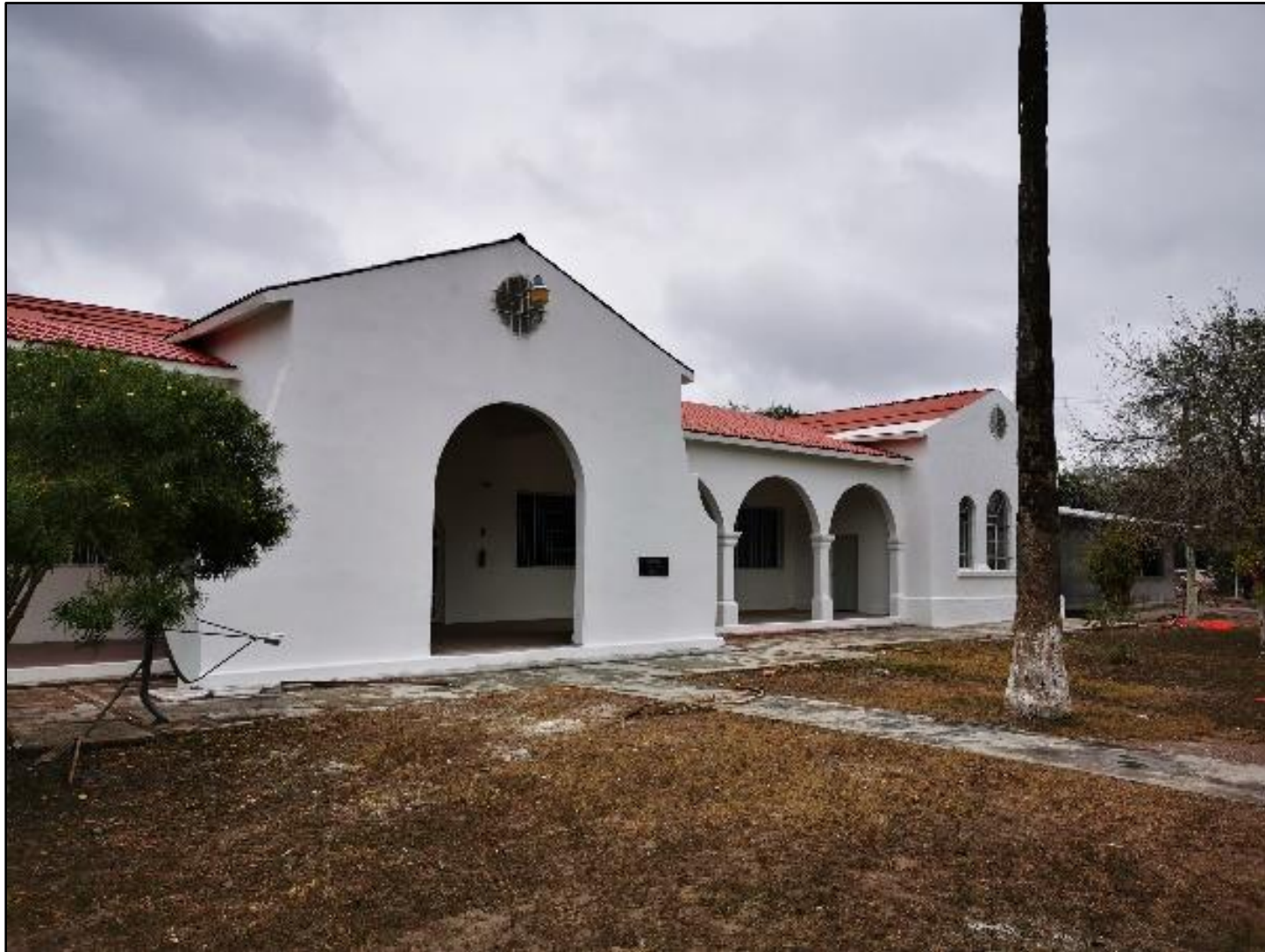
Figura 76. Estado actual de la fachada del inmueble
