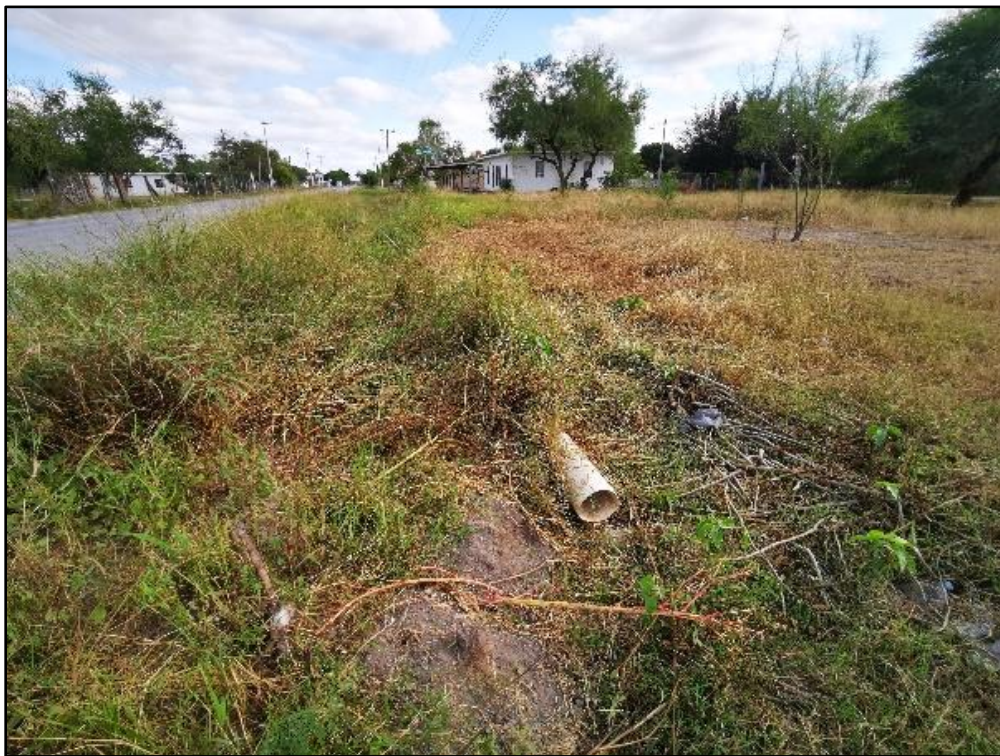
Figura 109. Obras pluviales insuficientes
