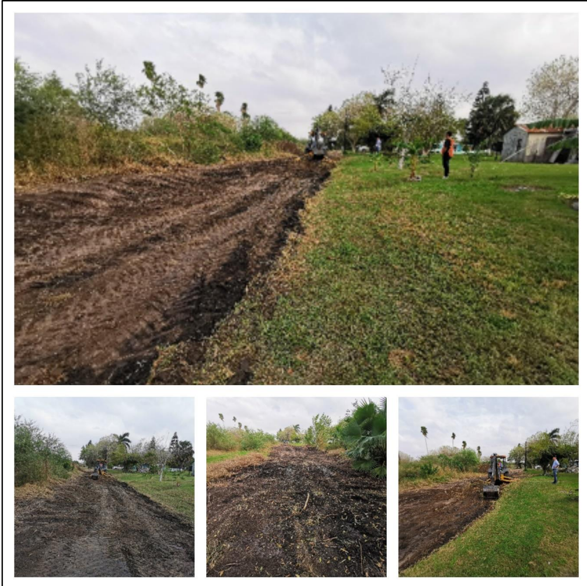
Figura 153. Vista general del avance de la obra en la primera semana.
