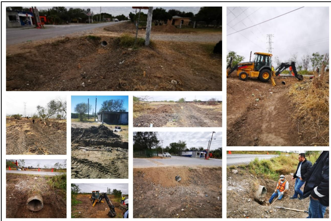
Figura 125. Estado general de la obra en el mes de diciembre
