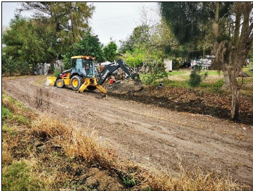
Figura 166. Maquinaria trabajando en drenes pluviales
