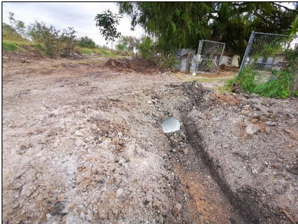
Figura 170. Estado final de la tubería instalada
