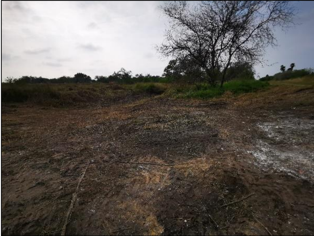
Figura 152. Limpieza del área al inicio de los trabajos
