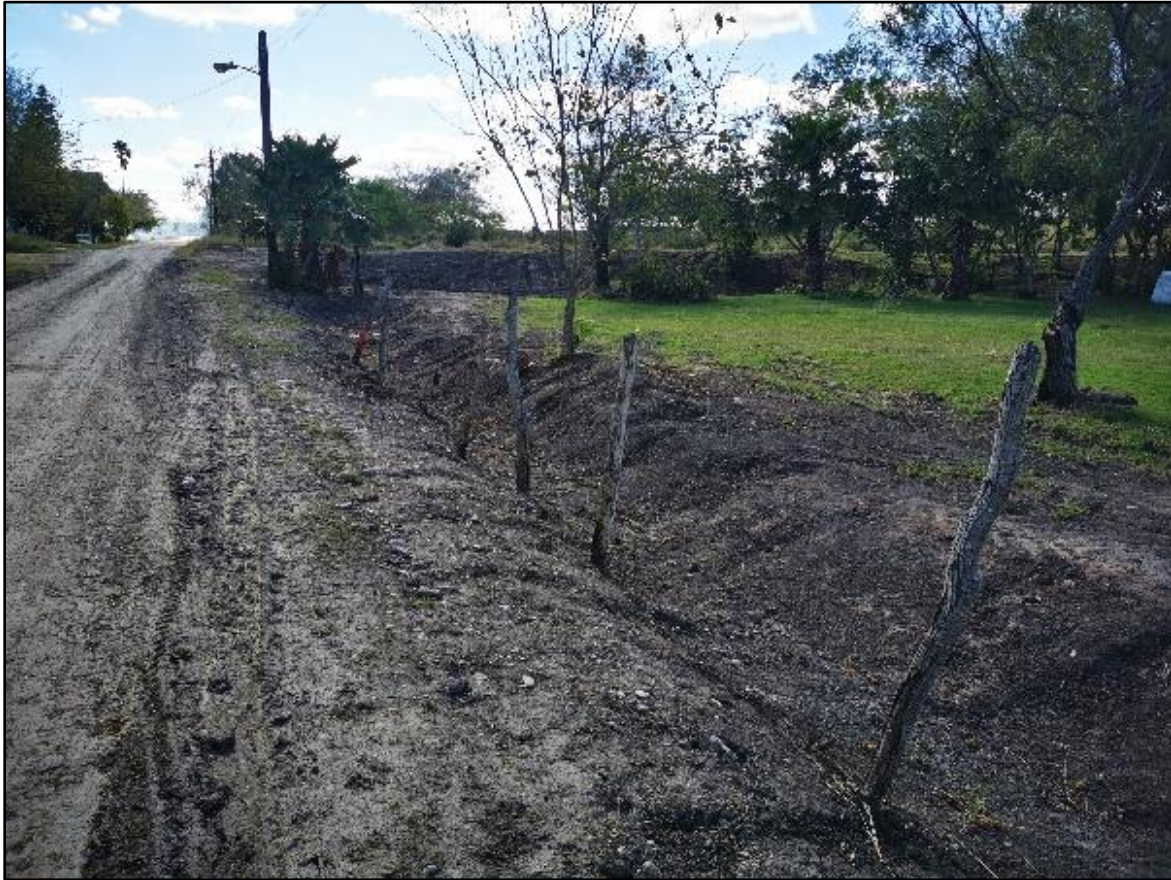
Figura 161. Limpieza y desazolve en drenes pluviales
