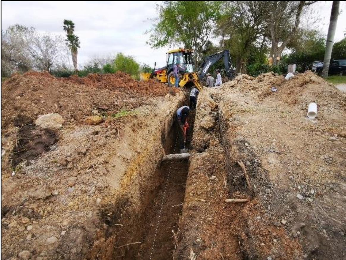
Figura 168. Trabajos de preparación para instalación de tubería pluvial.
