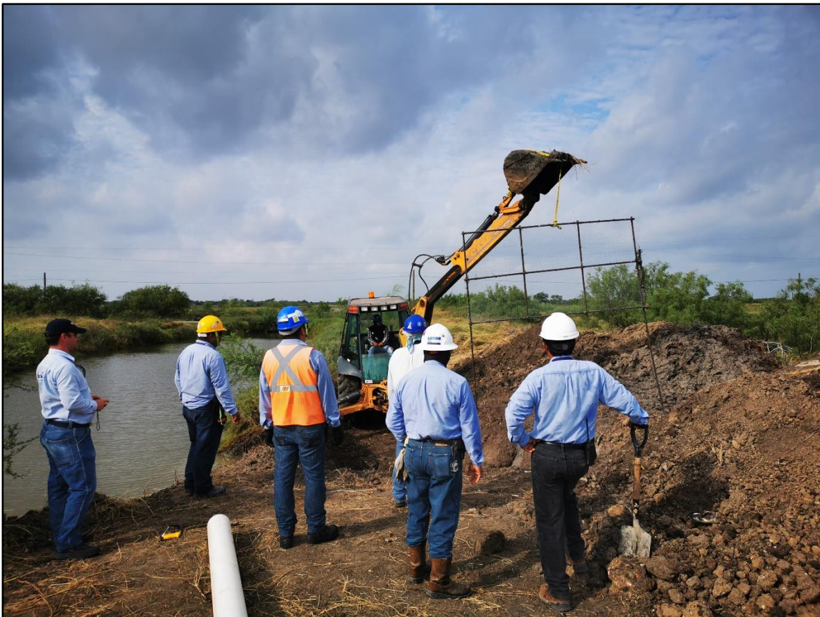
Figura 19. Empresas locales realizando trabajos en el Proyecto TRB
