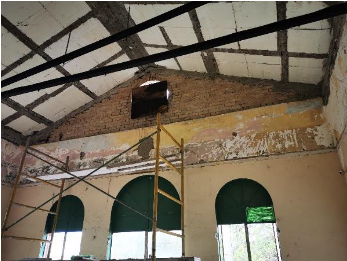
Figura 64. Retiro de plafón obsoleto
