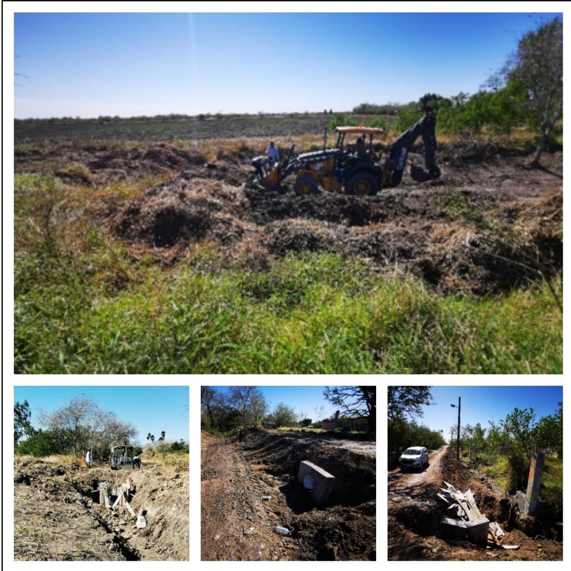
Figura 171. Vista general de los avances de obra en Santa Irene
