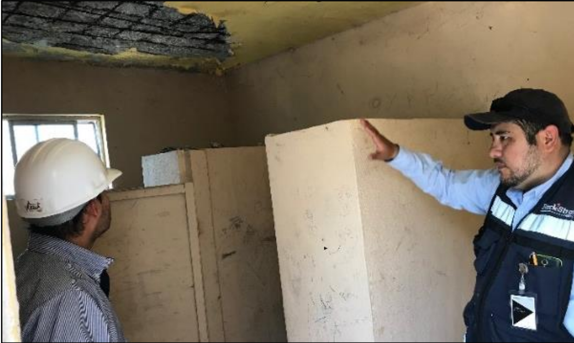
Figura 49. Inspección en los baños por parte del contratista
