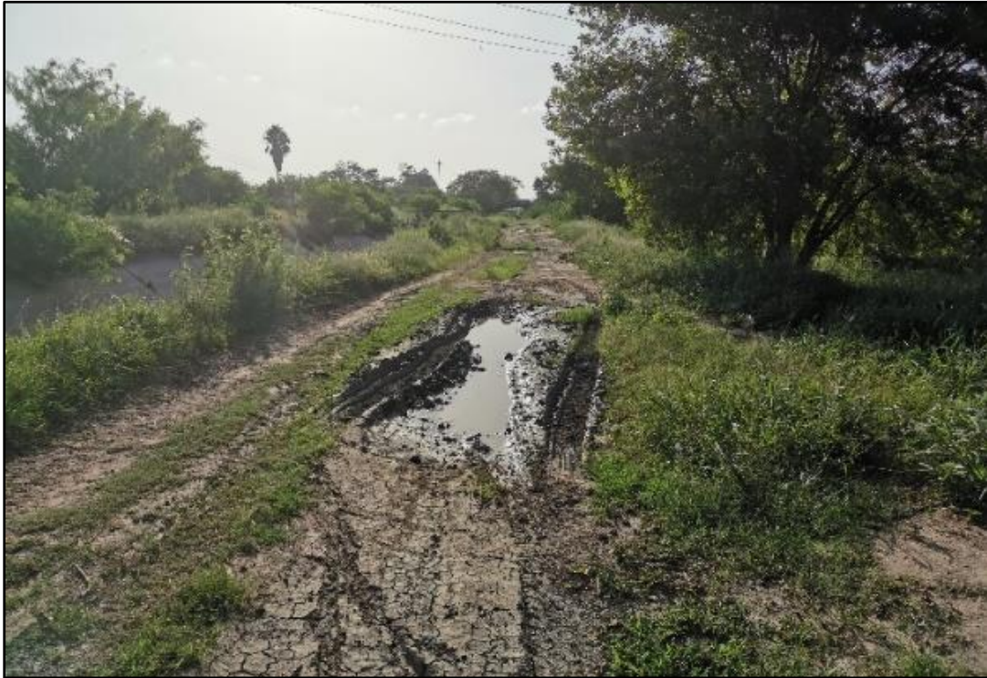
Figura 191. Estado inicial de las calles en El Sabinito
