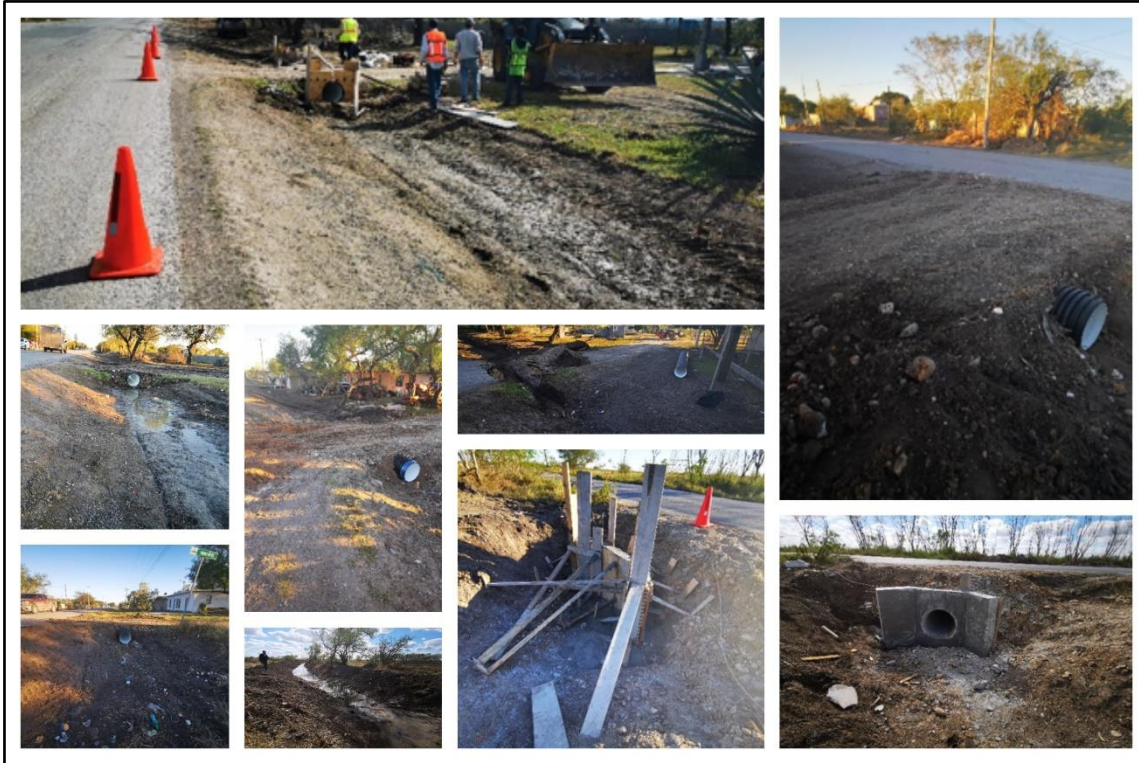
Figura 124. Vista general del avance obras en el mes de diciembre
