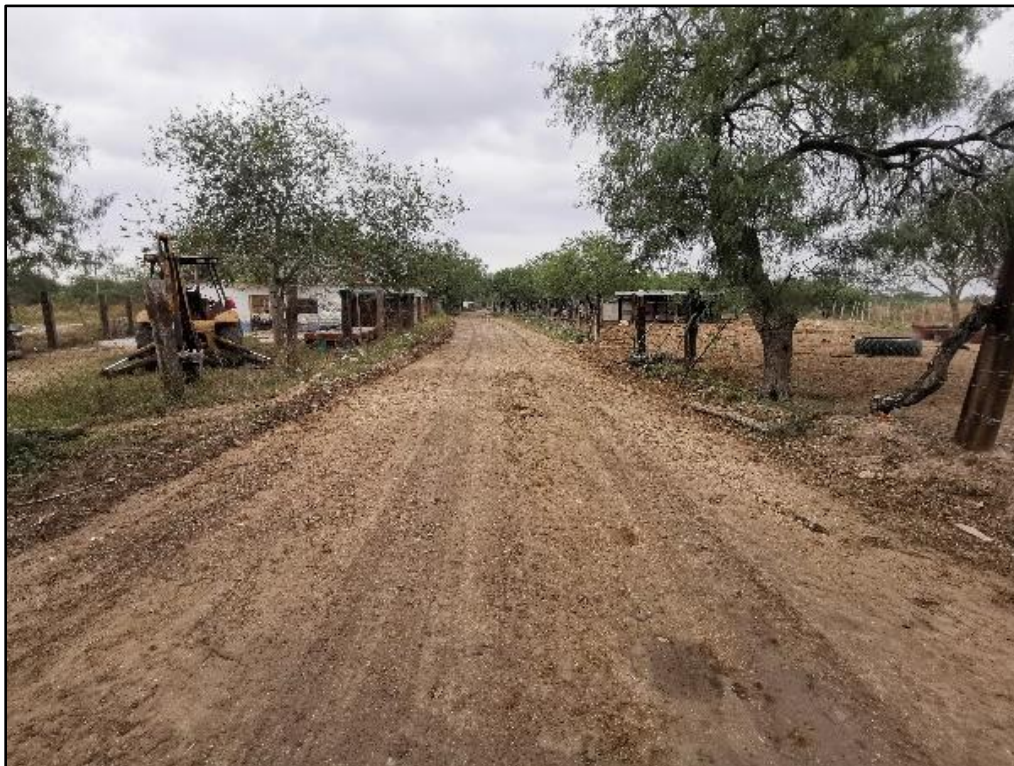
Figura 214. mejora de caminos en la comunidad El Sabino
