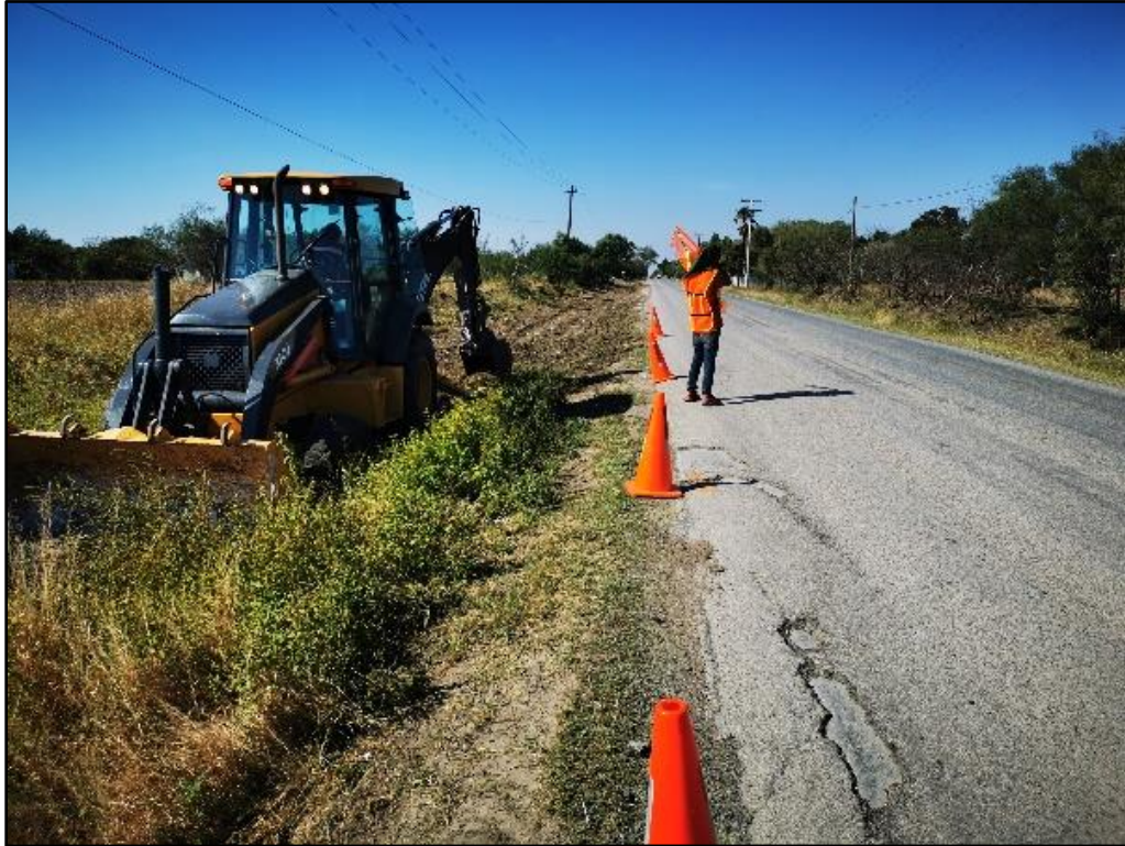
Figura 116. Señalización para trabajos con maquinaria
