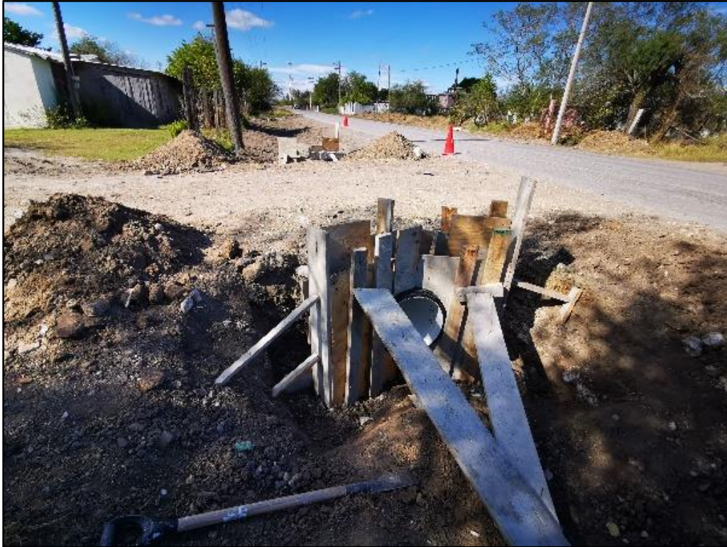
Figura 127. Construcción de cabezales de concreto
