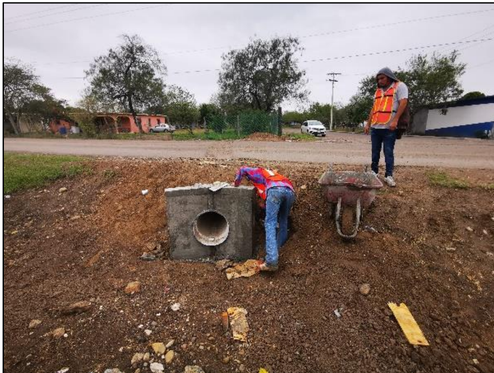
Figura 128. Cabezales de concreto que refuerzan la estructura de la obra
