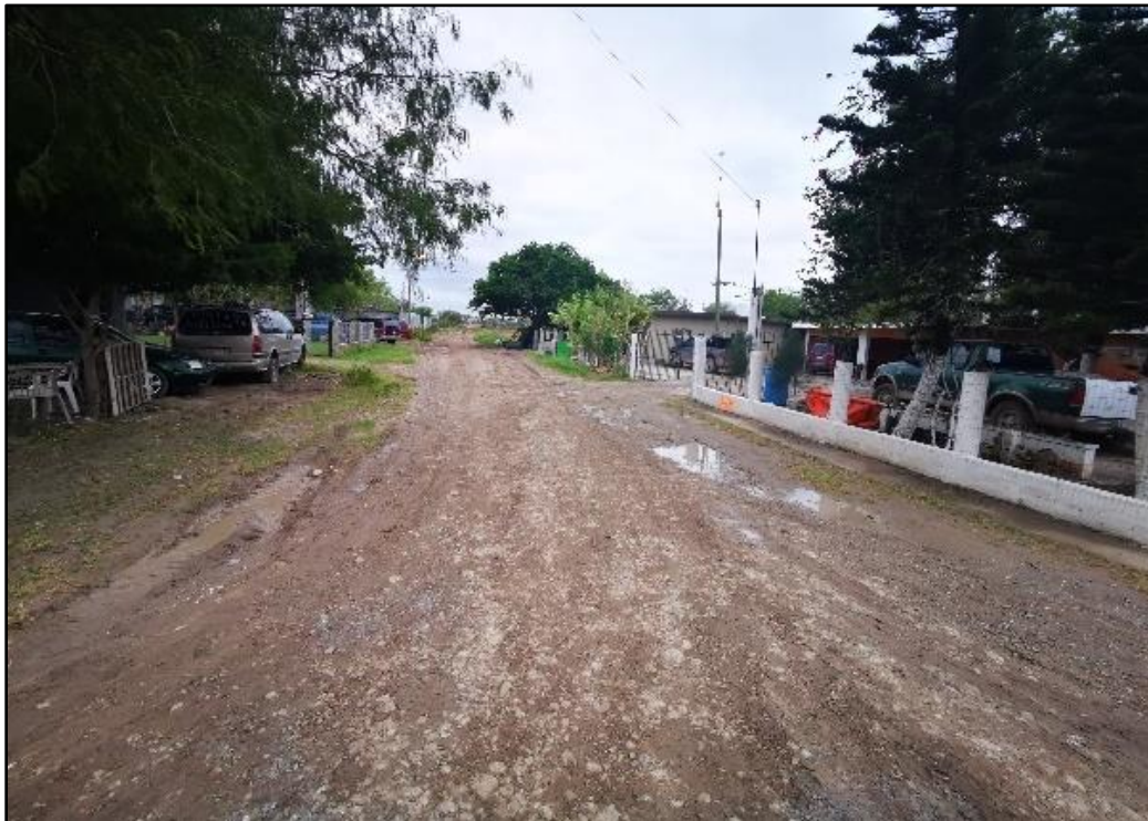
Figura 190. Calles en El Sabino antes de la rehabilitación
