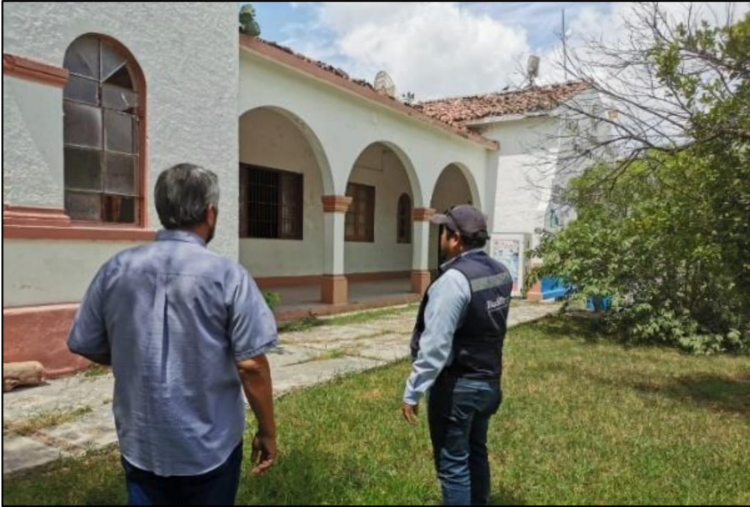
Figura 58. Revisión de la fachada del inmueble
