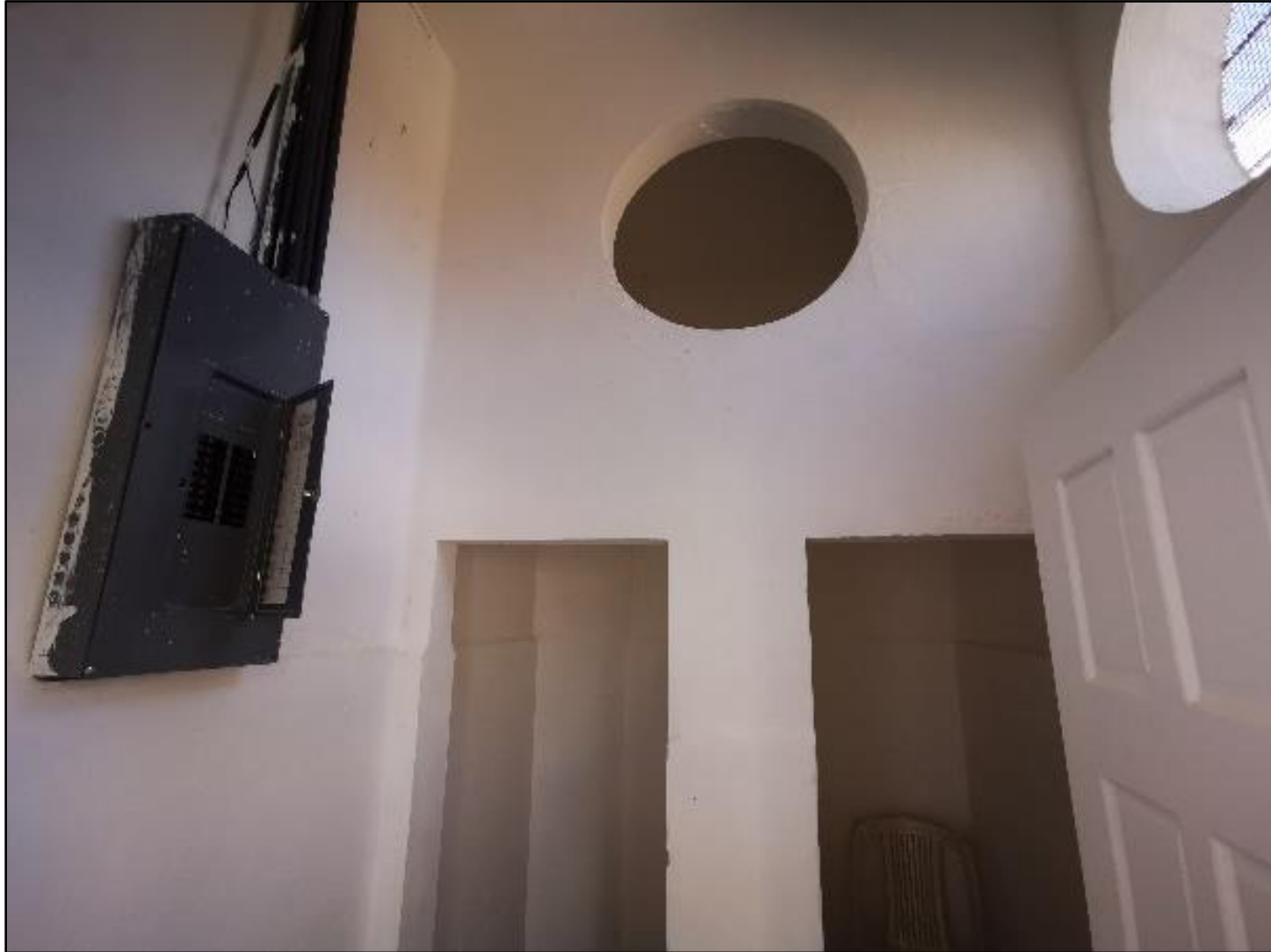
Figura 75.Rehabilitación de bodegas y nuevo tablero de control
