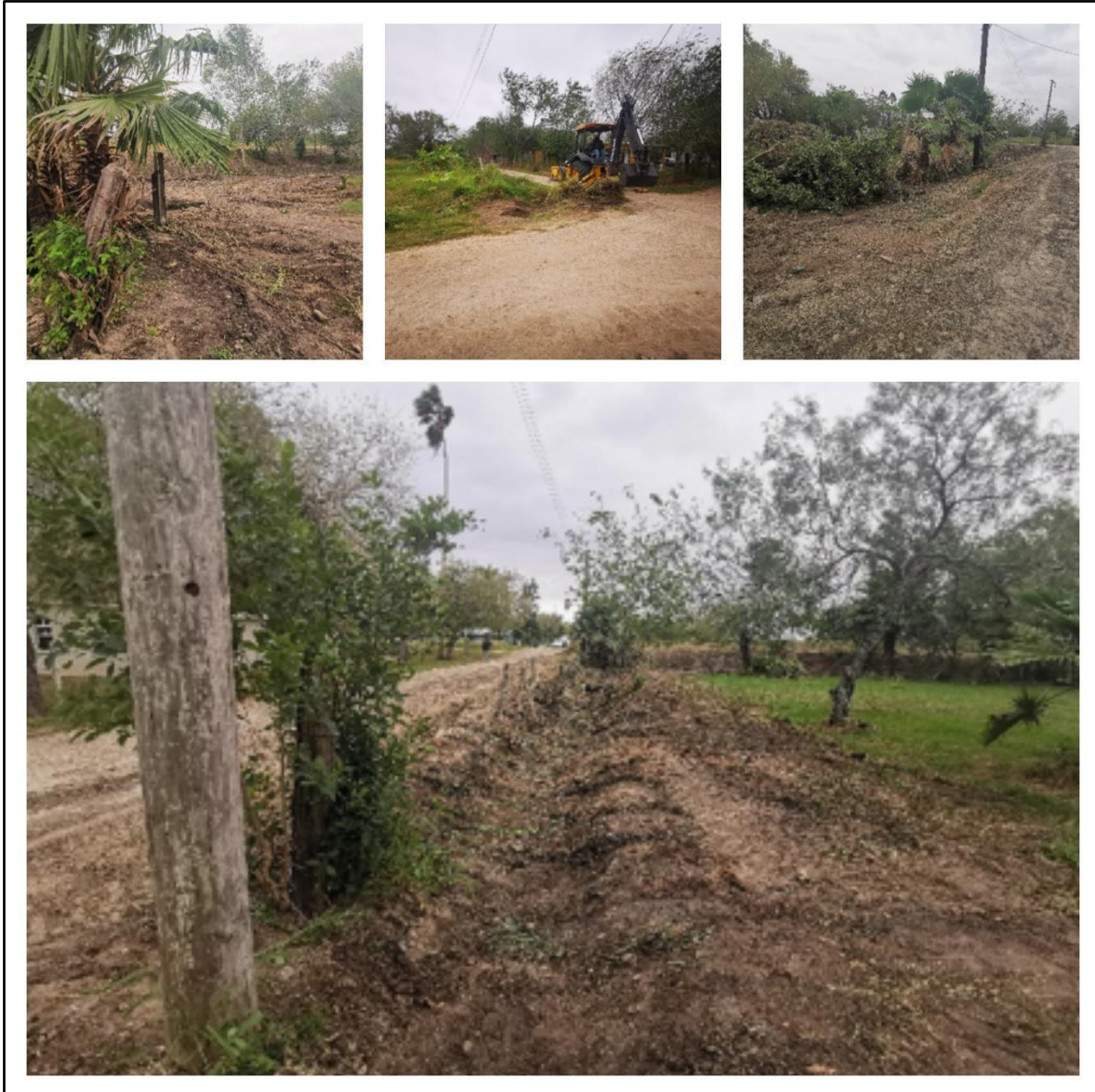
Figura 156. Vista general del avance de obras en la segunda semana
