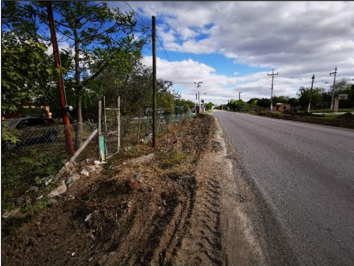
Figura 121. Avance en obras de rehabilitación de drenes pluviales
