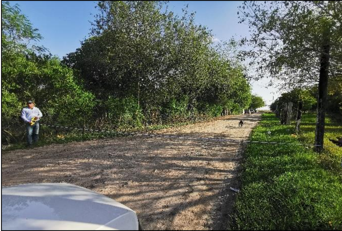
Figura 197. Estado de las calles en El Sabinito antes de la obra del PIS
