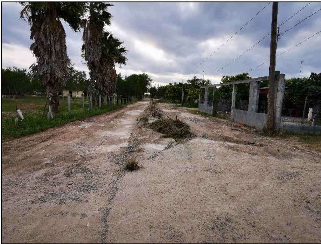
Figura 199. Preparación de las calles para rehabilitación
