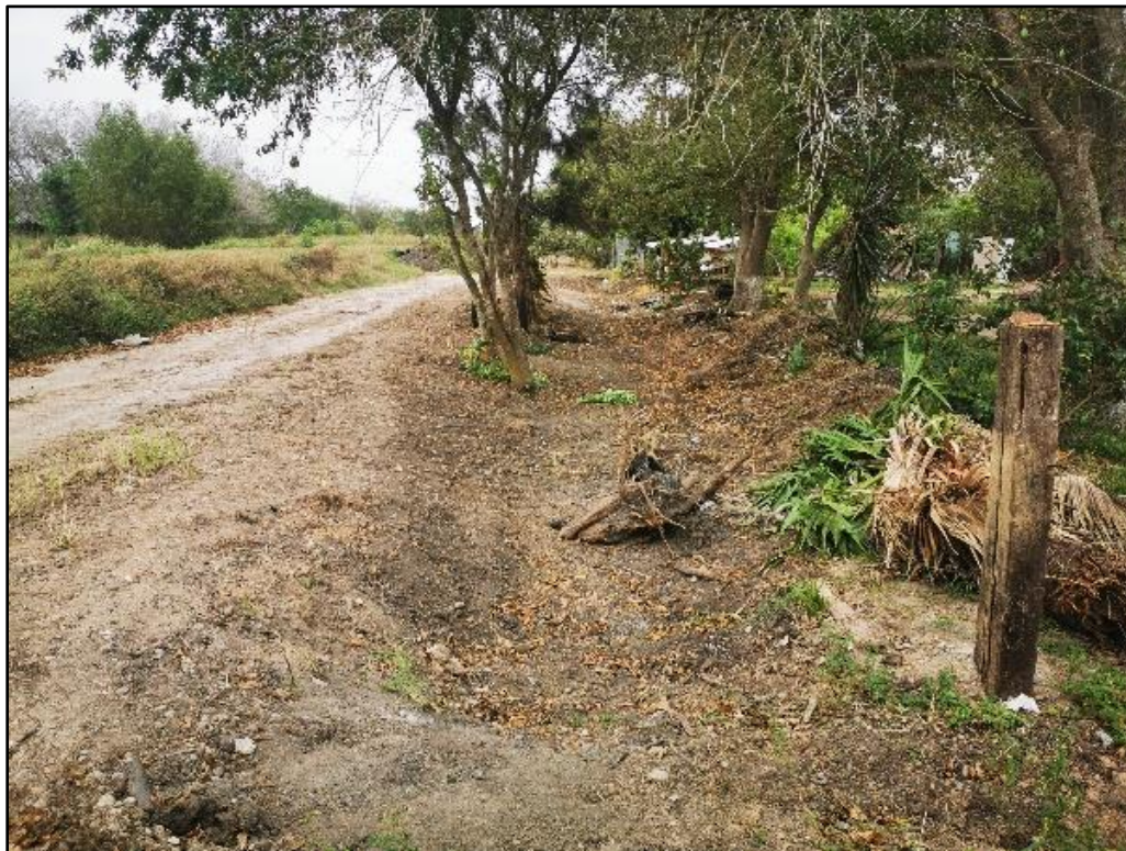
Figura 155. Trabajos de limpieza en los drenes pluviales de Santa Irene
