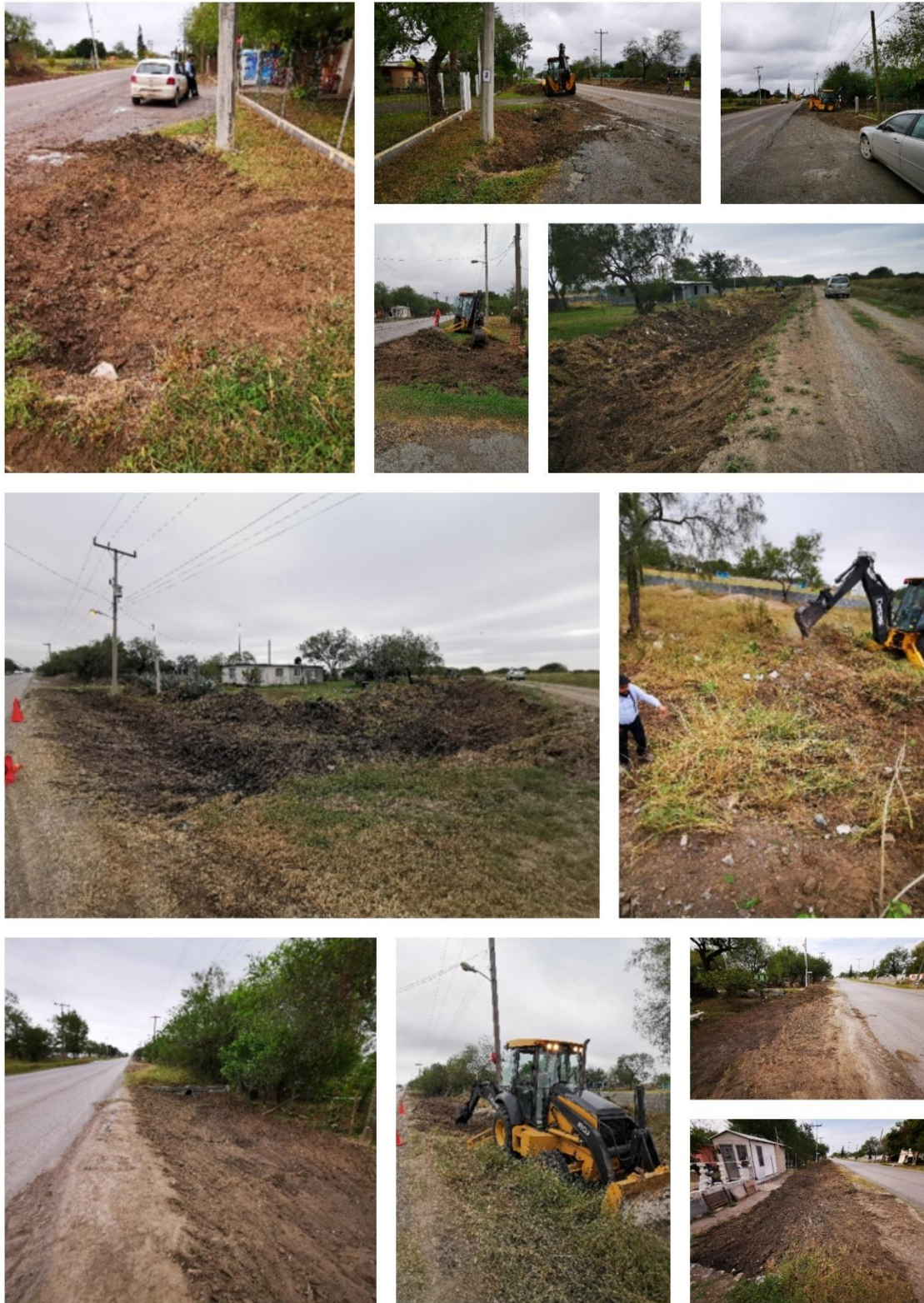
Figura 119. Vista general de los trabajos del PIS en el mes de noviembre
