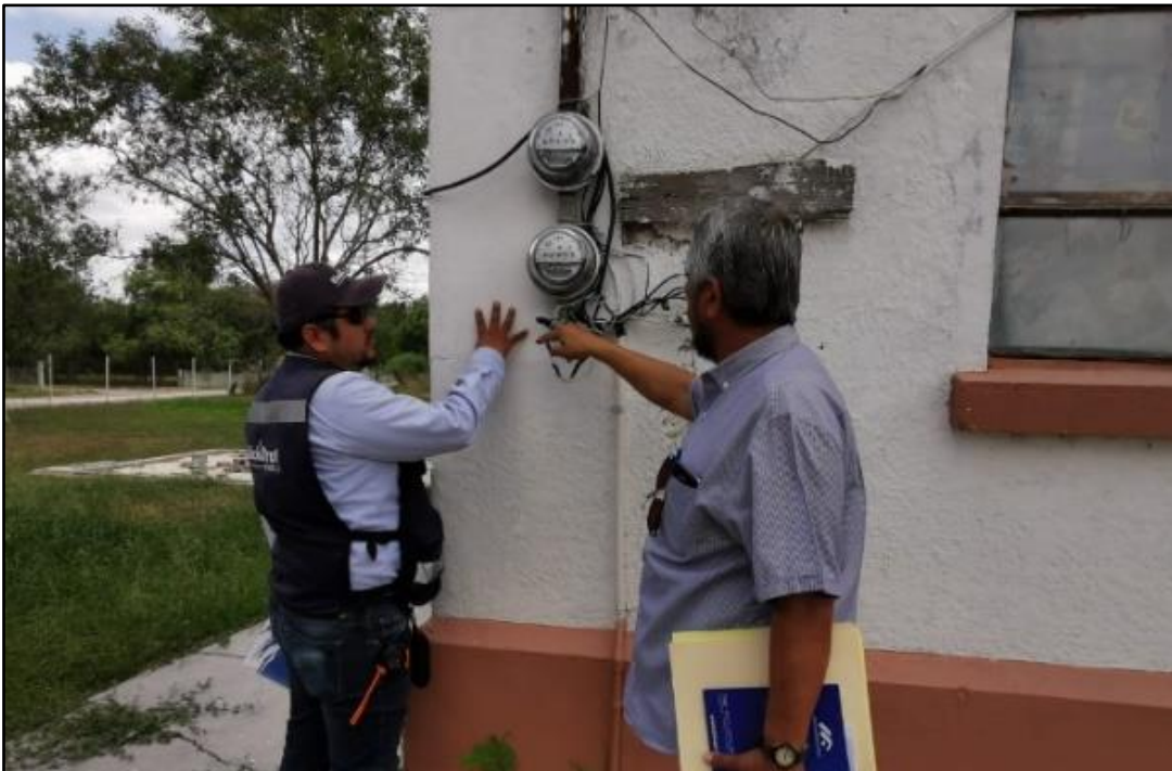
Figura 59. Inspección de la instalación eléctrica
