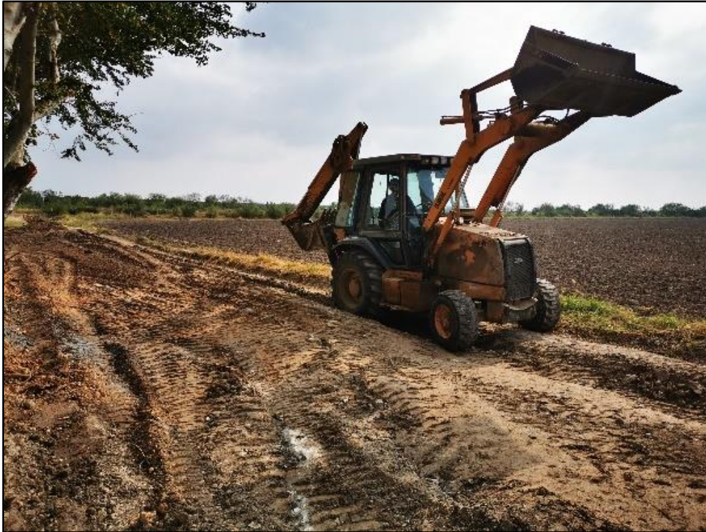
Figura 210. Maquinaria haciendo trabajos finales en El Sabino
