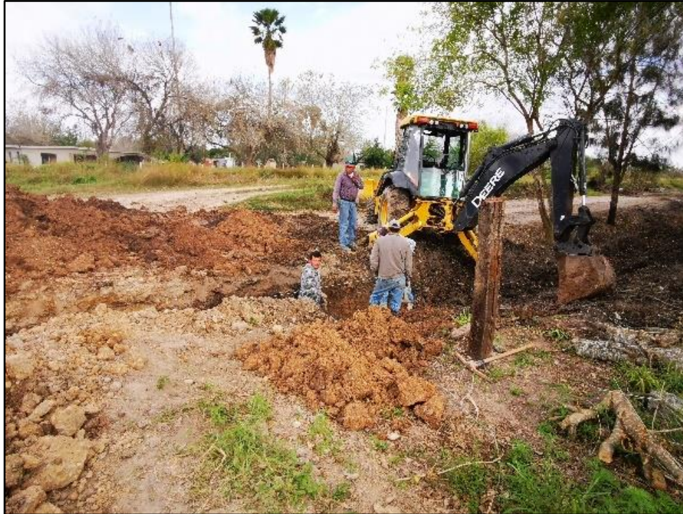
Figura 169. Trabajos con maquinaria para instalación de tubería pluvial
