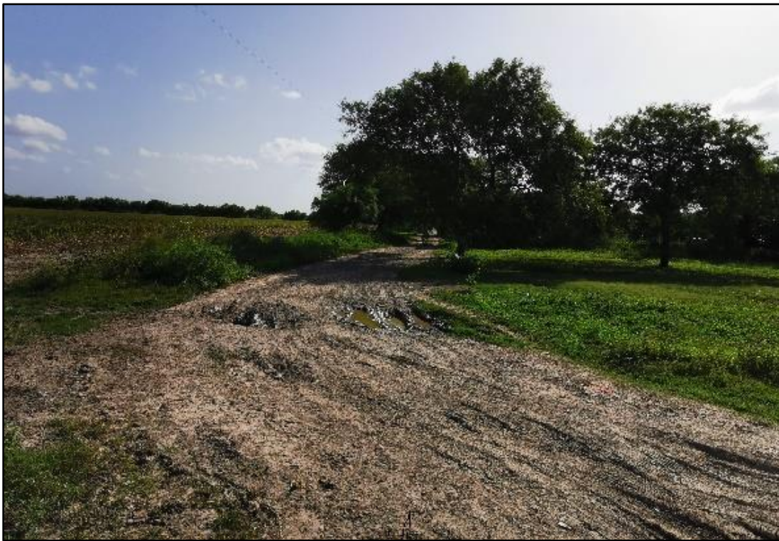
Figura 188. Estado inicial de las calles en El Sabino
