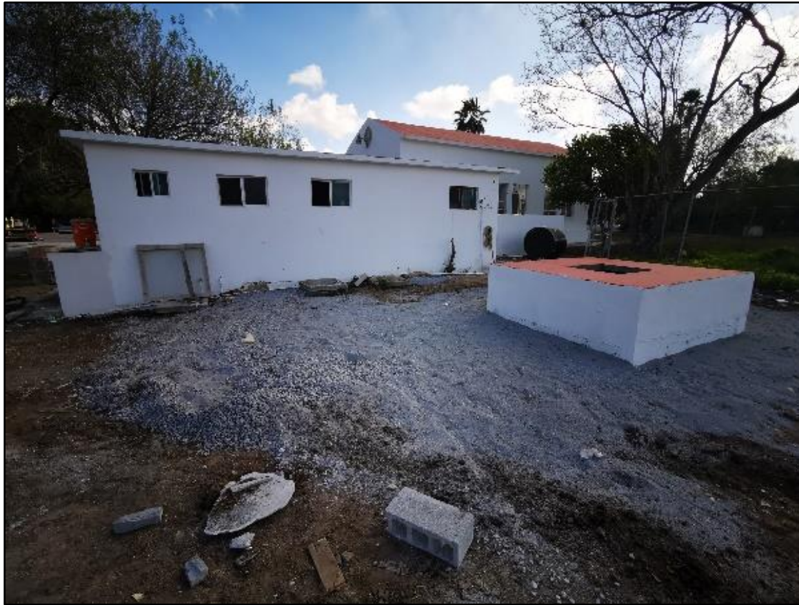
Figura 72. Nueva cisterna para los baños
