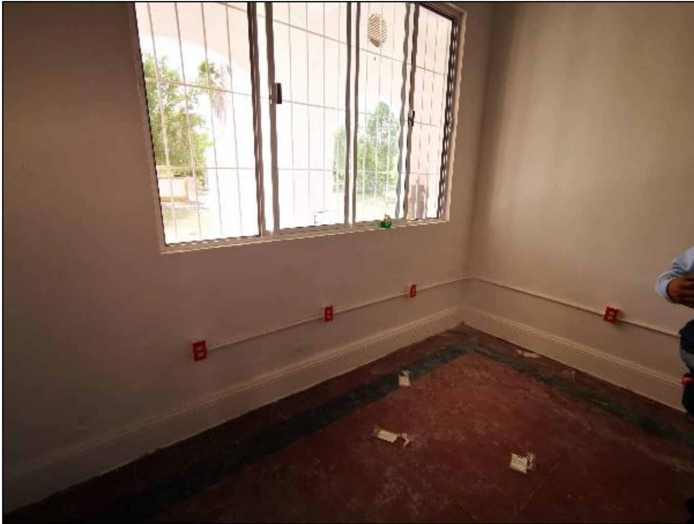
Figura 74. Nueva instalación eléctrica en aulas.
