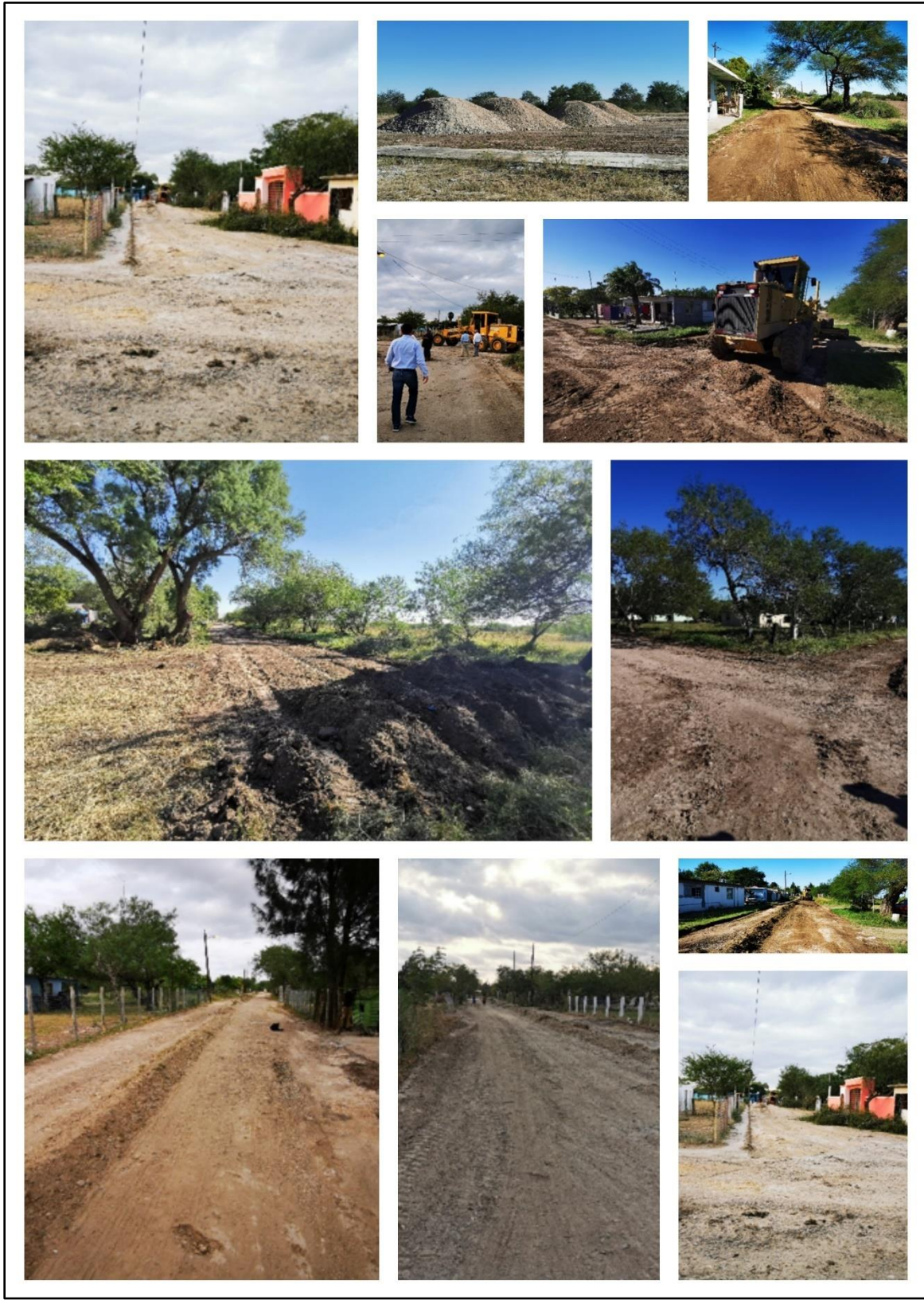
Figura 204. Avance general en obras de rehabilitación de caminos
