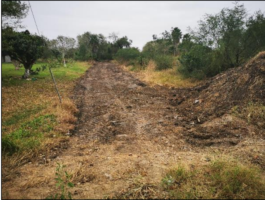
Figura 154. Limpieza de los drenes pluviales
