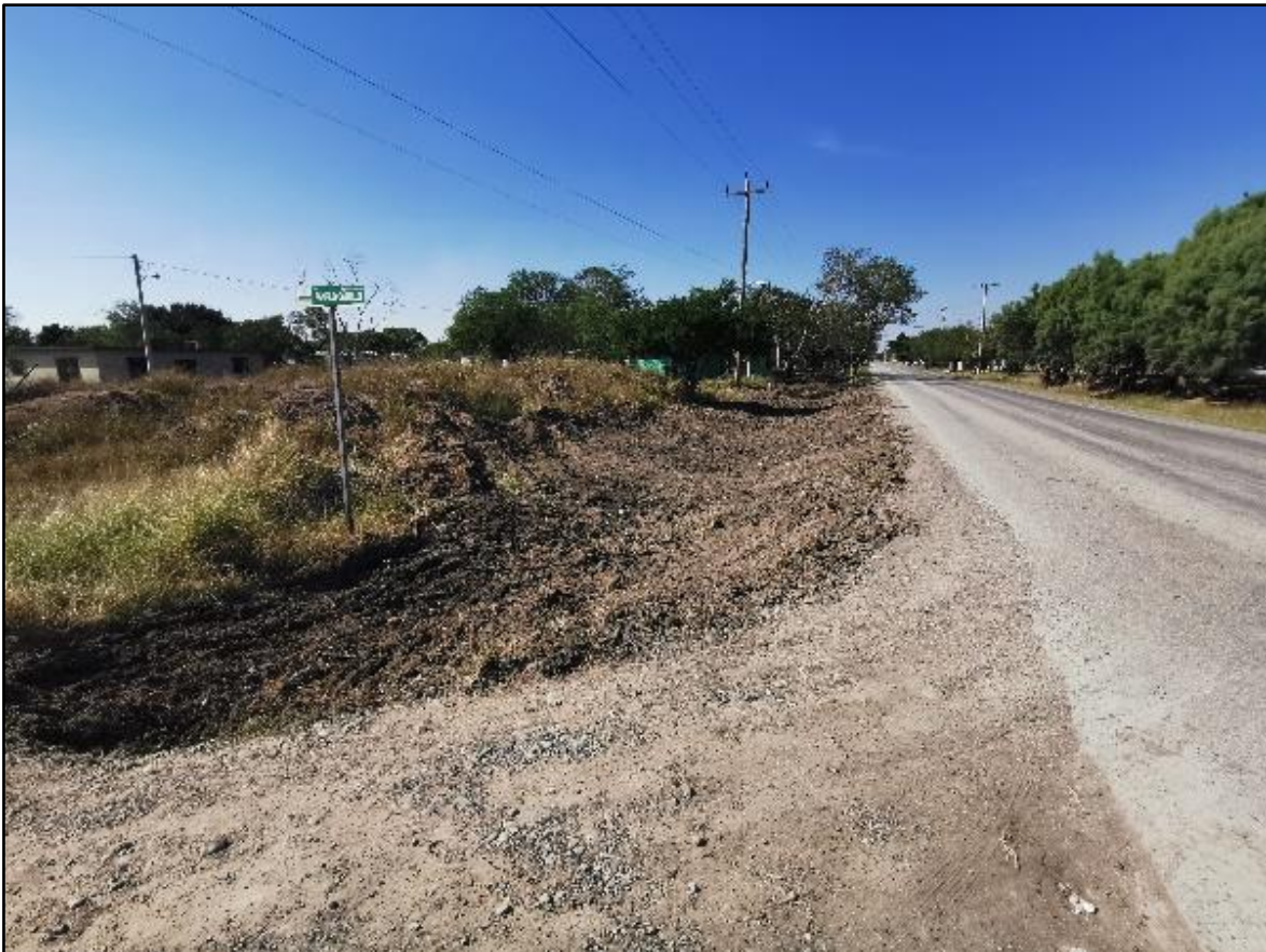
Figura 115. Limpieza inicial de los drenes pluviales
