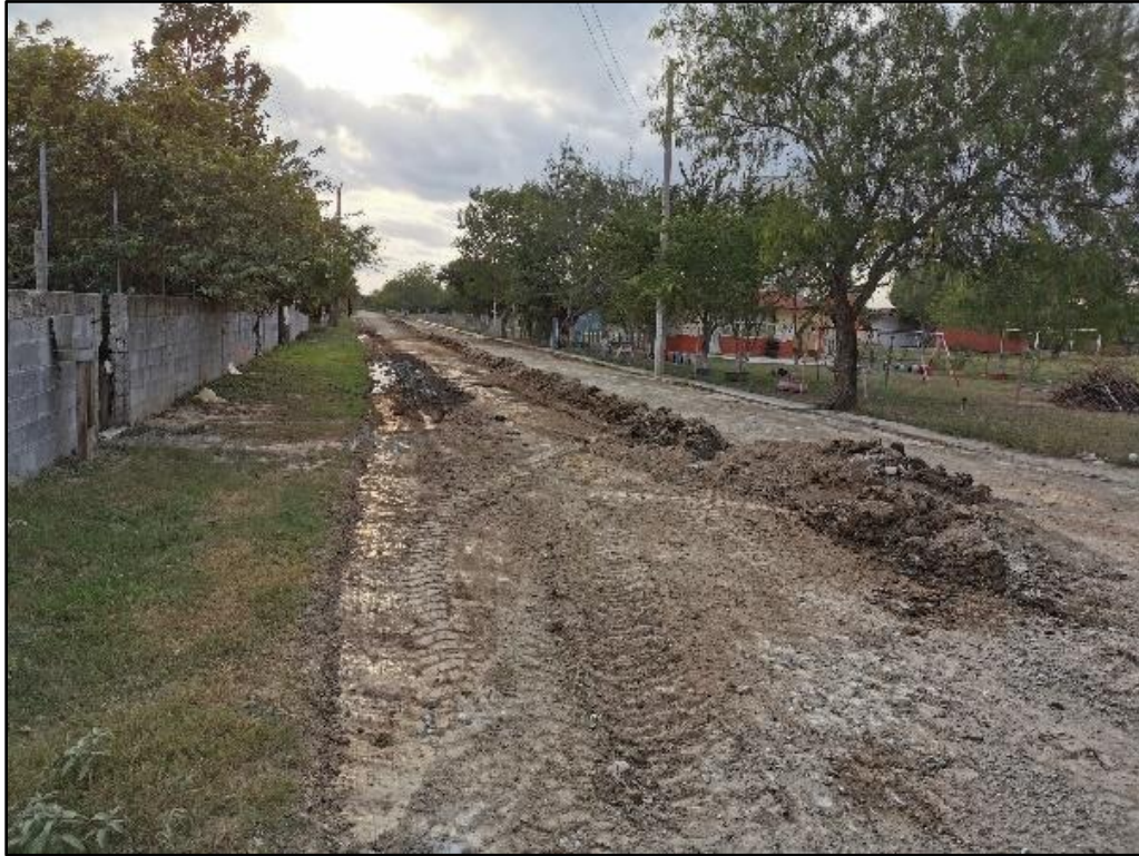
Figura 198. Inicio de obras en El Sabino
