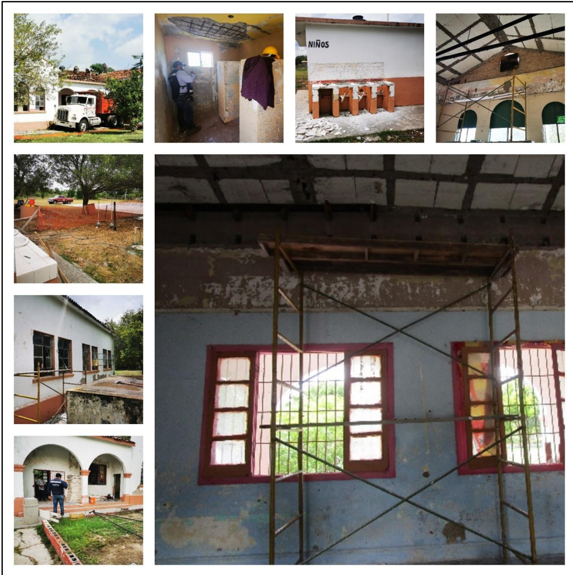
Figura 65. Vista general de los trabajos durante septiembre
