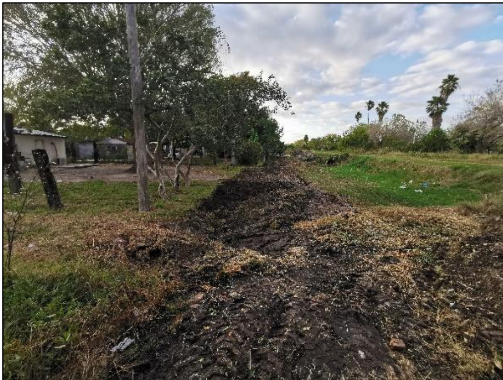
Figura 151. Trabajos iniciales en la comunidad Santa Irene
