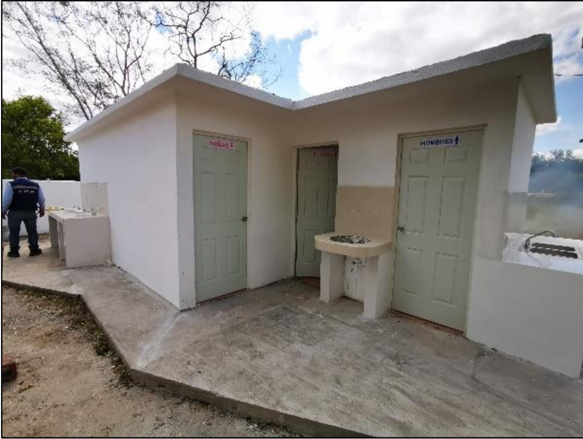
Figura 68. Rehabilitación de instalaciones sanitarias
