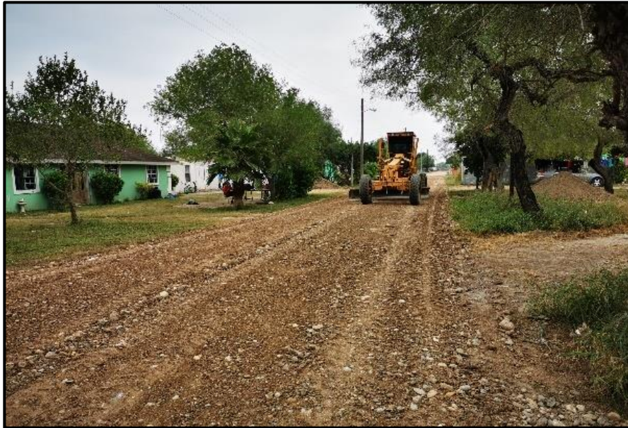
Figura 205. Trabajos en las calles de El Sabino
