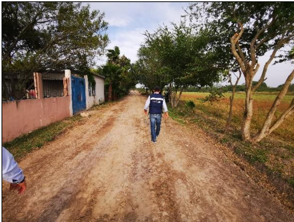
Figura 208. Primeras calles rehabilitadas en El Sabino
