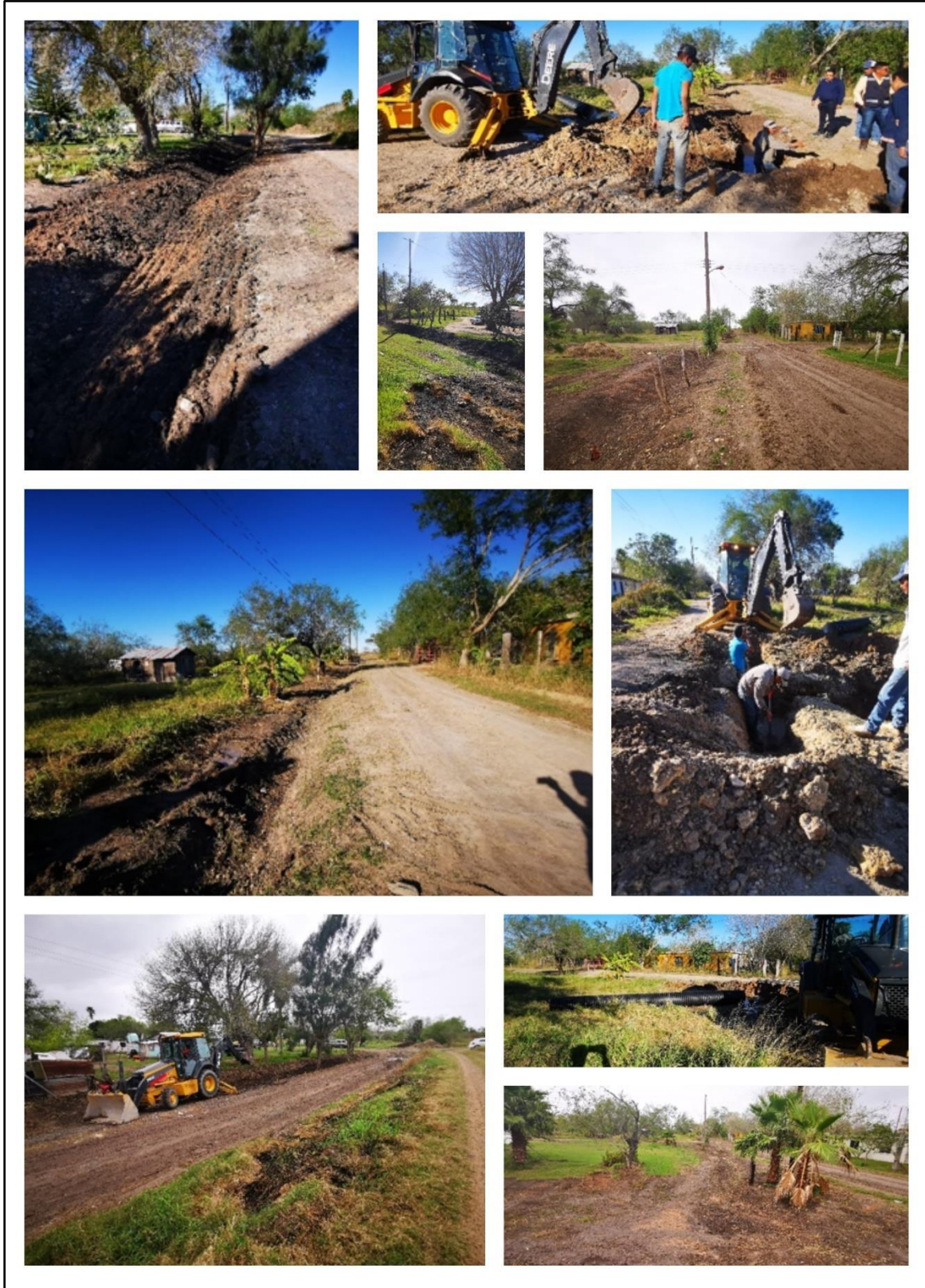
Figura 167. Vista general del avance obras en Santa Irene
