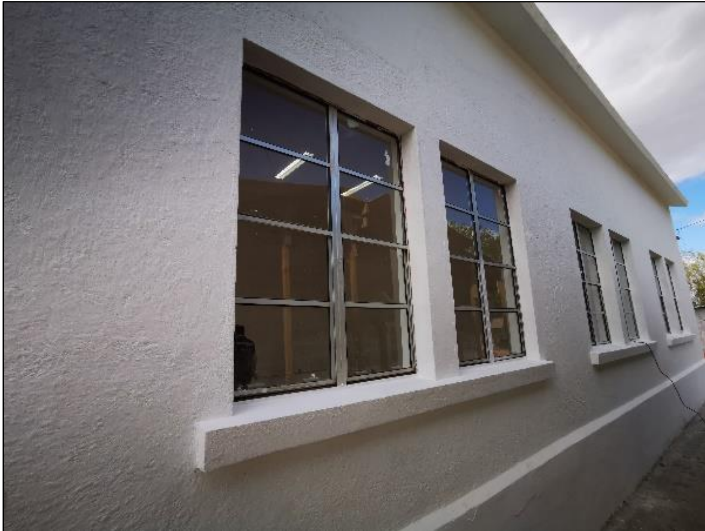
Figura 79. Rehabilitación de ventanas y cambio de vidrios
