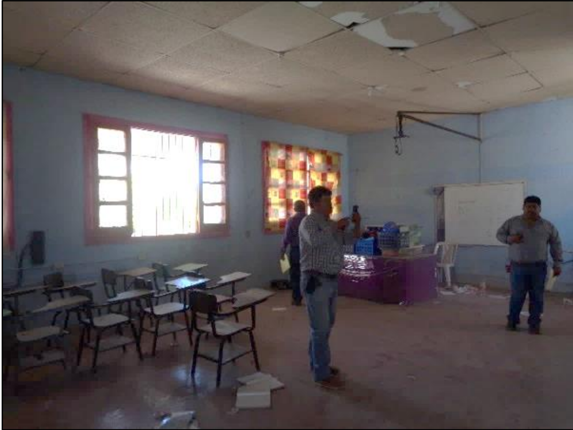
Figura 62. Visita de contratistas a escuela primaria Lázaro Cárdenas
