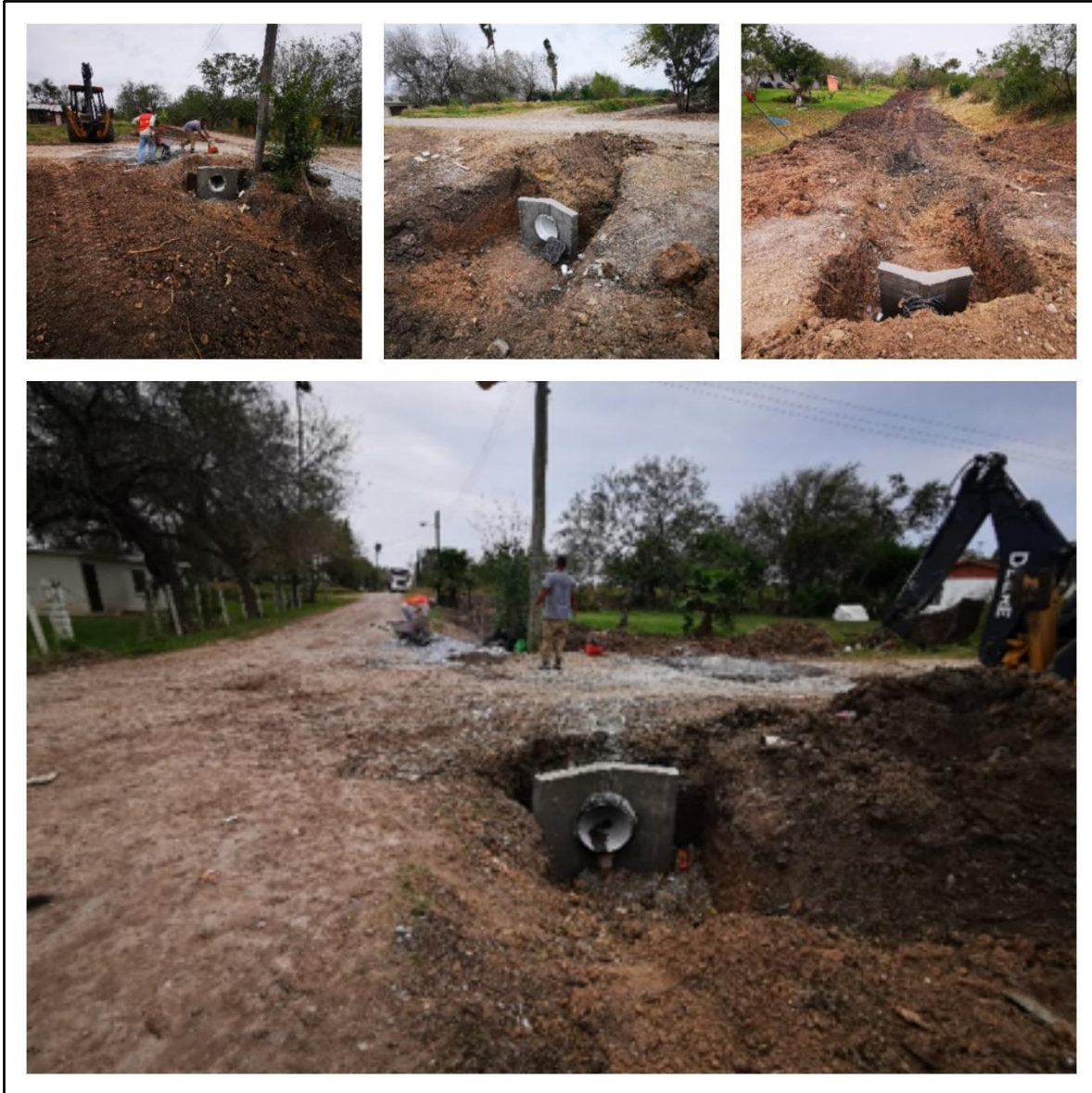
Figura 172. Nuevos cabezales de concreto en tubería pluvial
