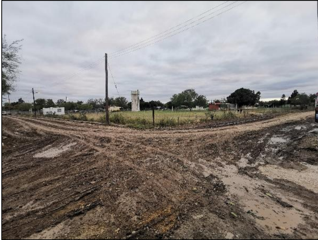
Figura 189. Estado de las calles en EL Sabino antes de las obras del PIS
