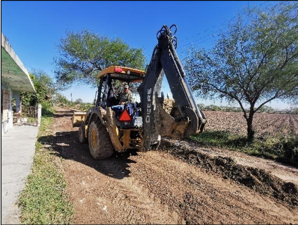
Figura 202. Maquinaria trabajando en la comunidad El Sabino
