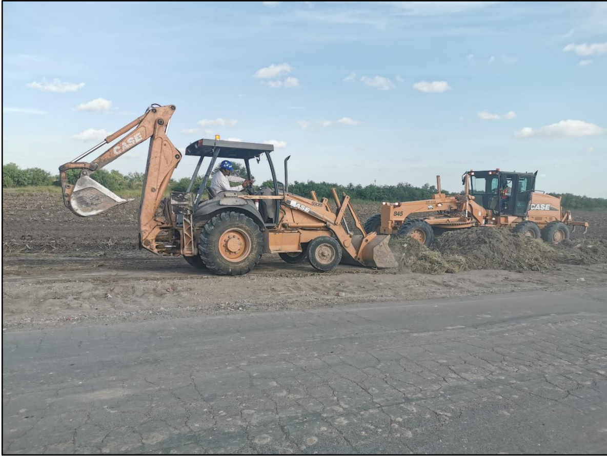
Figura 20. Empresas locales realizando trabajos en el Proyecto TRB
