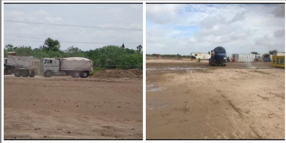
Figura 10. Evidencia del Programa de Riego de Caminos y Zonas de Obra
