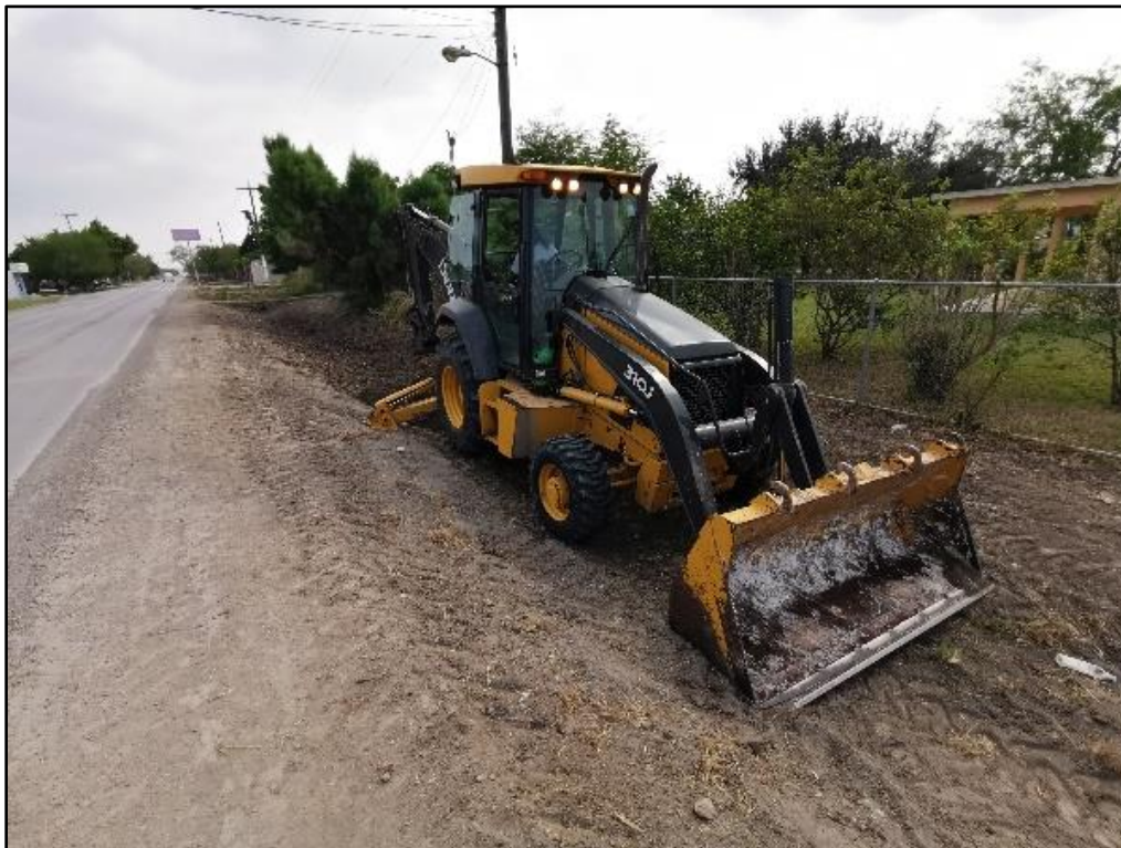
Figura 123. Maquinaria en zona de trabajo
