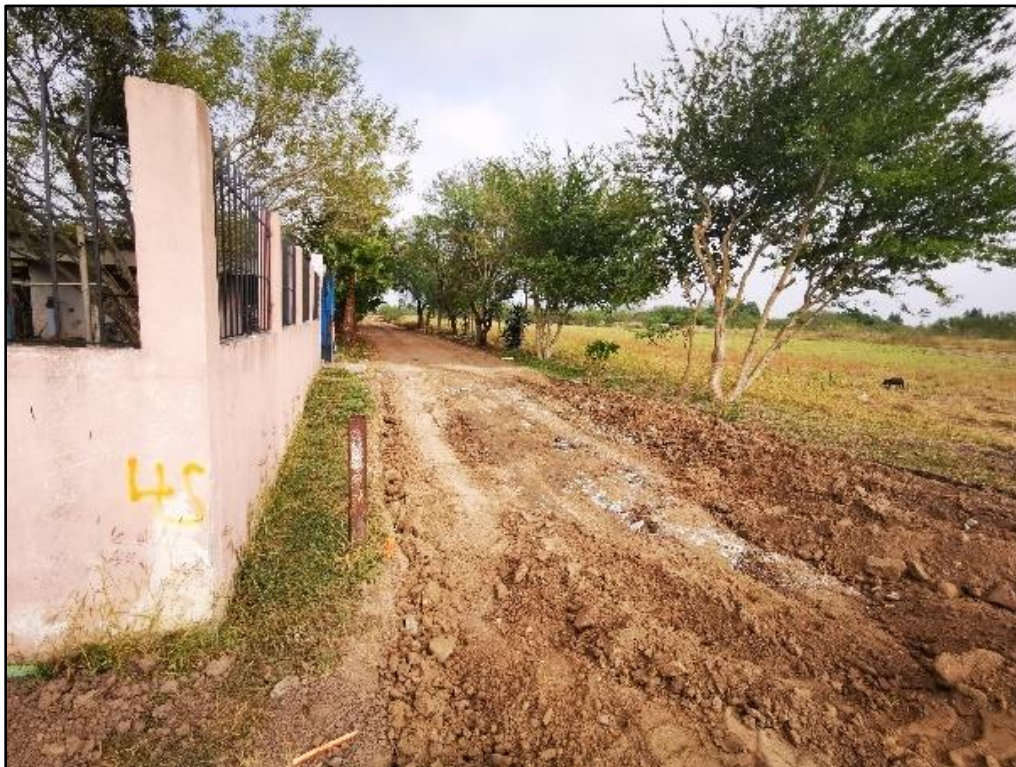
Figura 212. Trabajos en comunidad El Sabino
