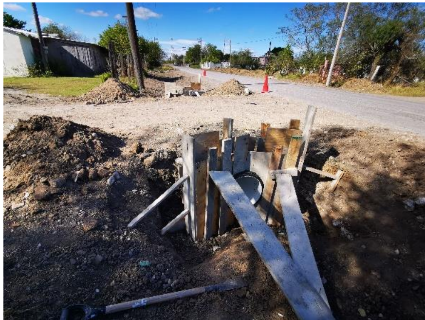
Figura 79. Construcción de cabezales de concreto
