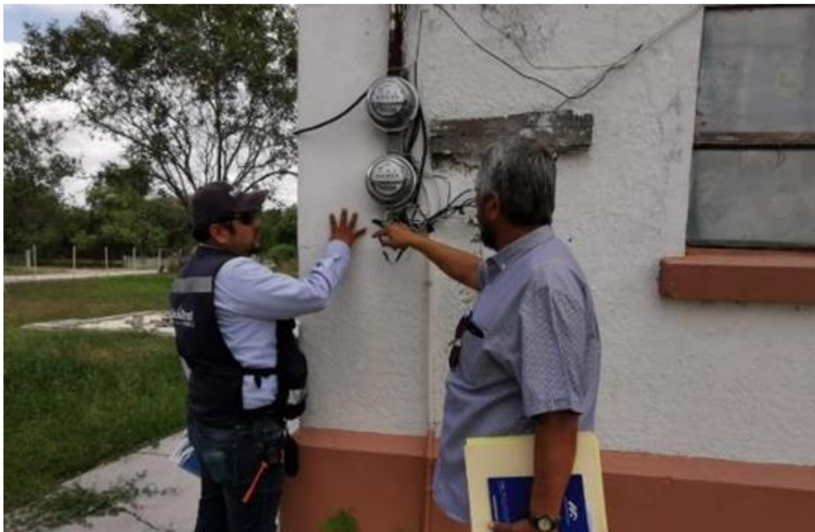
Figura 57. Inspección de la instalación eléctrica
