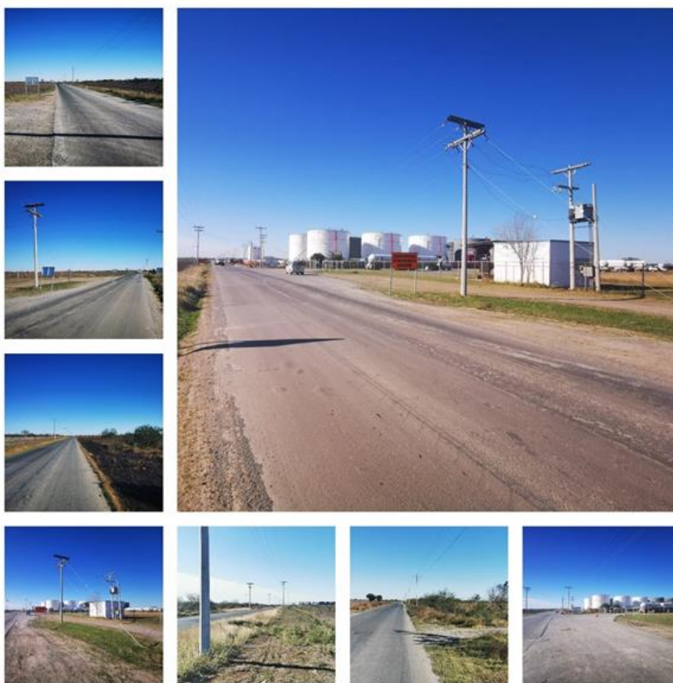
Figura 7. Instalación final de componentes de la Línea de transmisión
