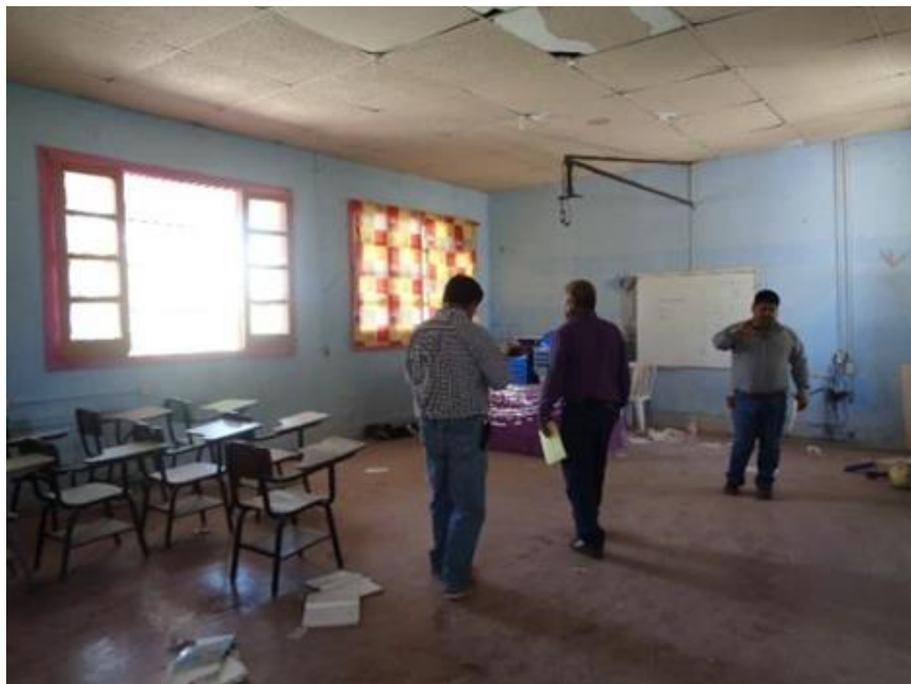
Figura 59. Recorrido de inspección por parte de contratistas locales
