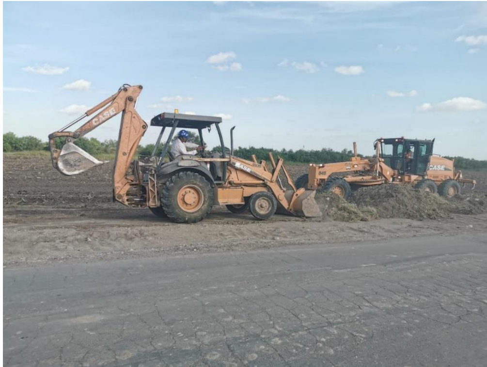
Figura 19. Empresas locales que efectuaron trabajos en las instalaciones del Proyecto
