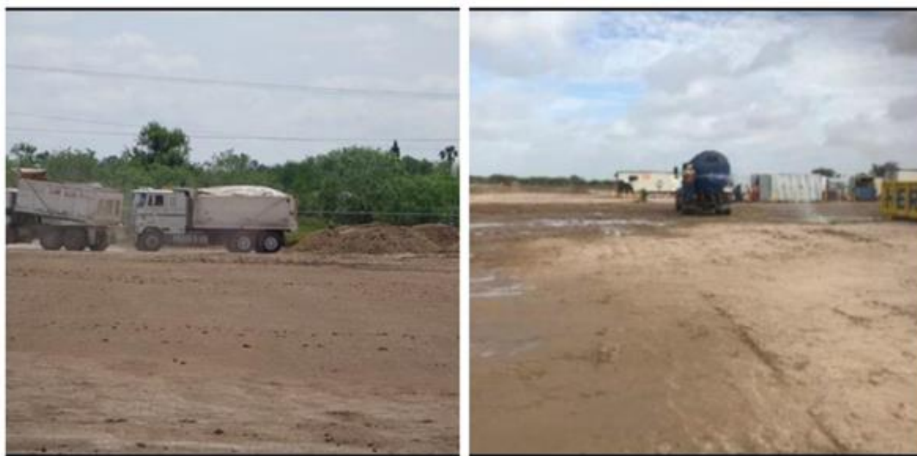
Figura 10. Evidencia de cumplimiento efectuado con respecto del Programa de Riego de Caminos y Zonas de Obra
