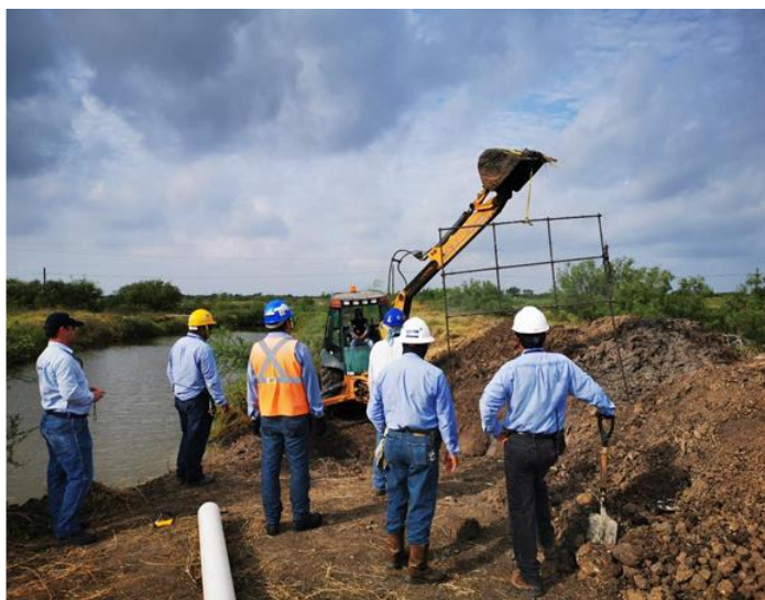
Figura 18. Empresas locales realizando trabajos en el Proyecto
