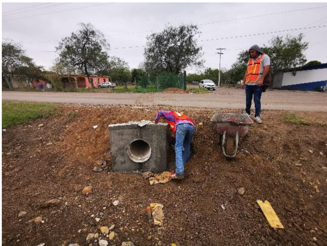
Figura 80. Cabezales de concreto que refuerzan la estructura de la obra
