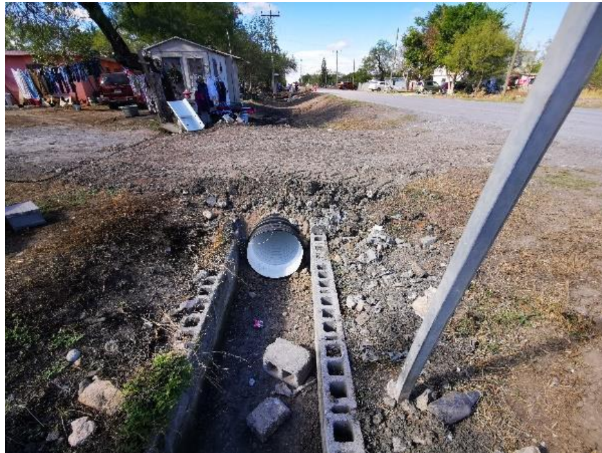
Figura 78. Instalación de tuberías en cruce de calles.
