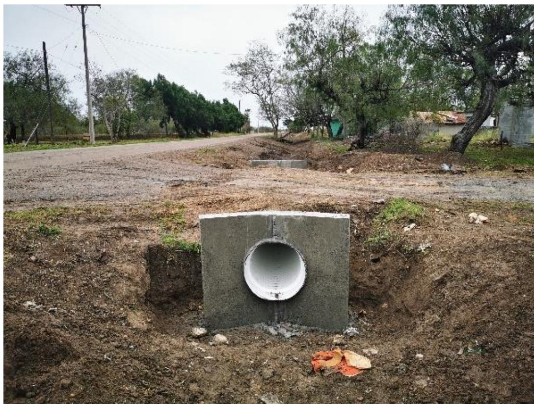
Figura 81. Vista final de la tubería pluvial instalada
