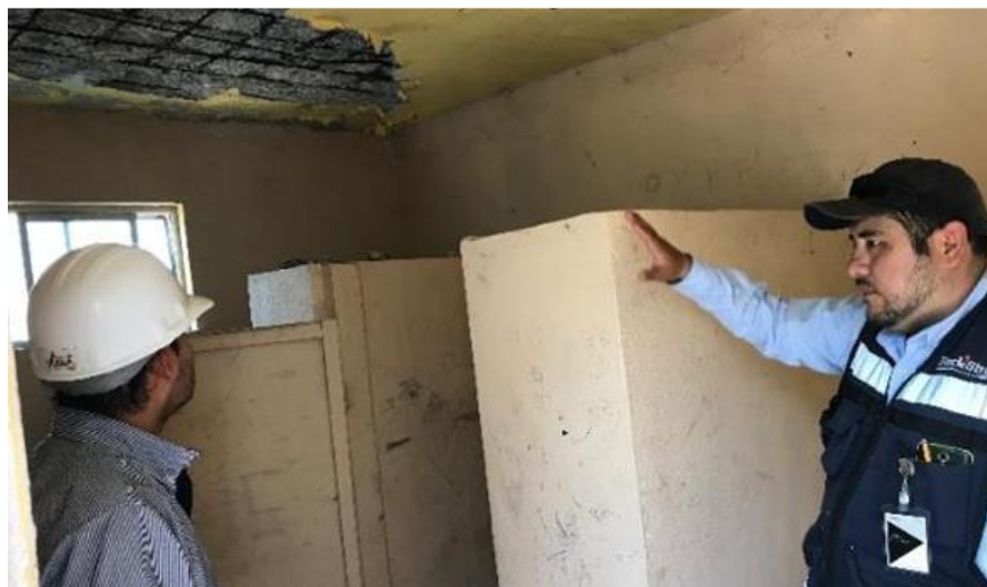
Figura 47. Inspección en los baños por parte del contratista
